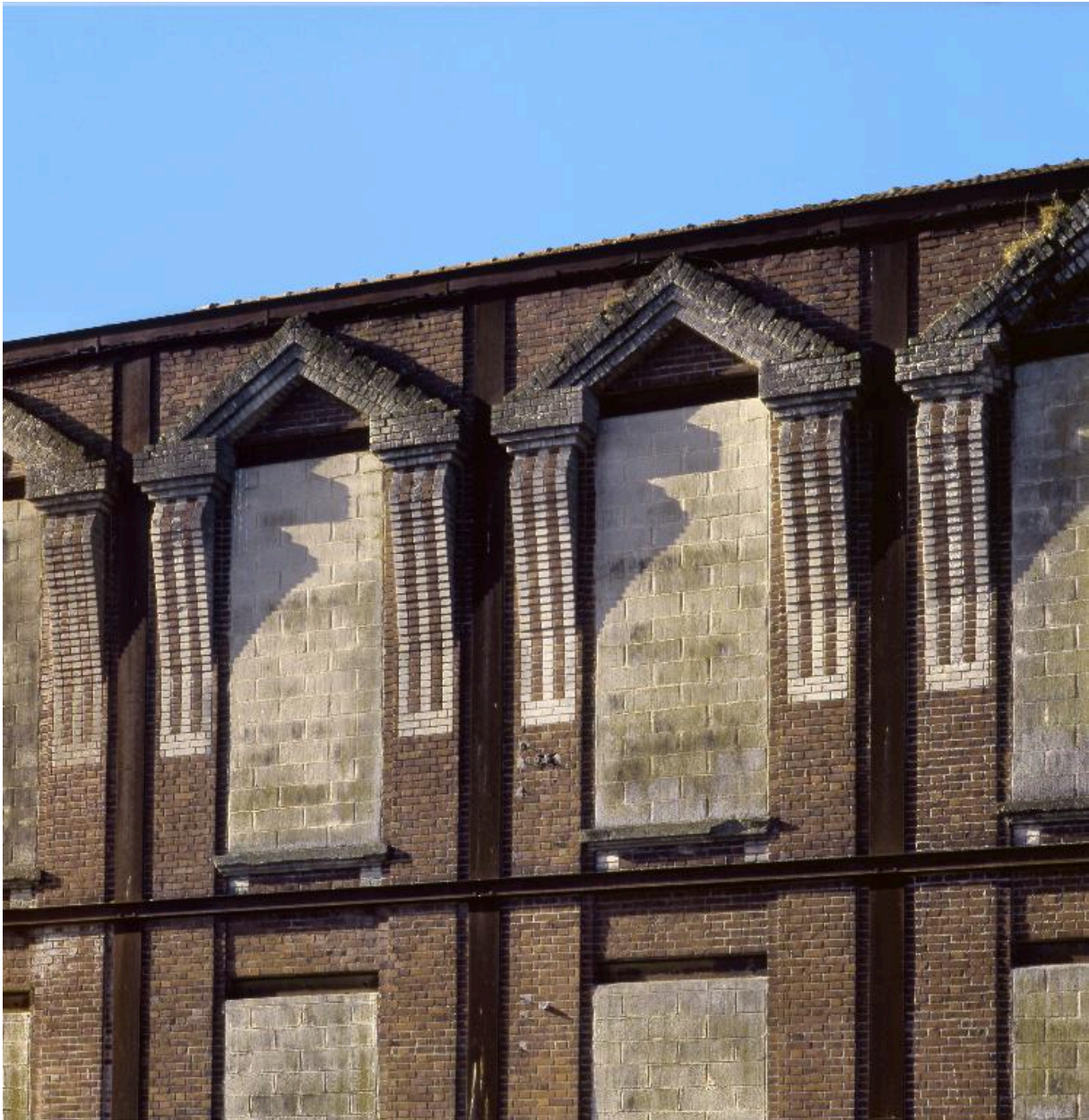
Détail du décor de brique en encadrement de baie.
