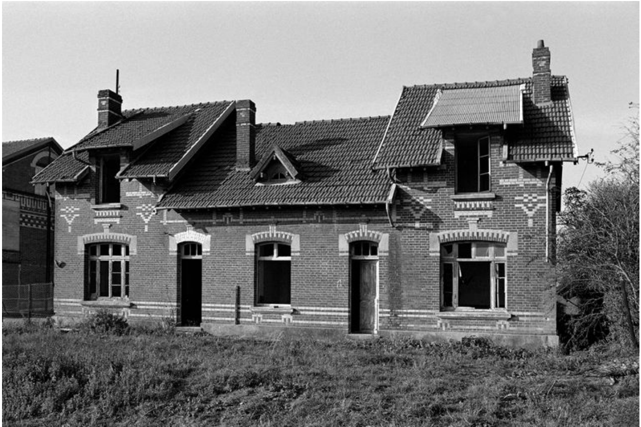
Logement de contremaître.
