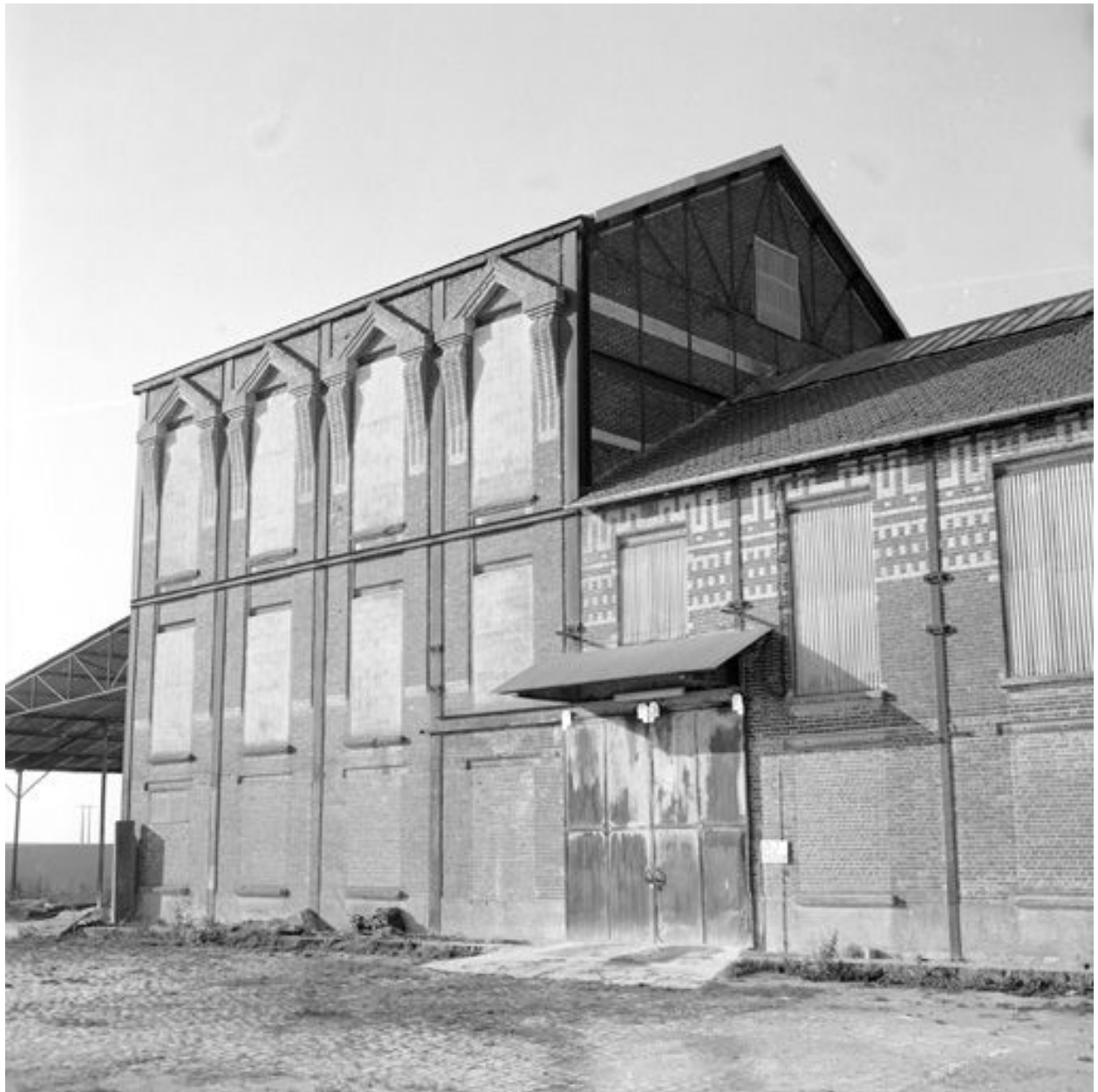
Atelier principal, flanc est. Détail.
