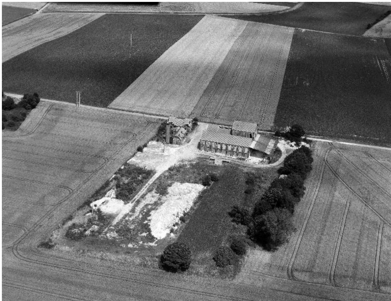
Vue aérienne, flanc ouest.
