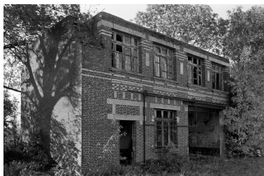
Dépendance sud, élévation nord. Phot. Francis Dubuc IVR22_19908001243Z
