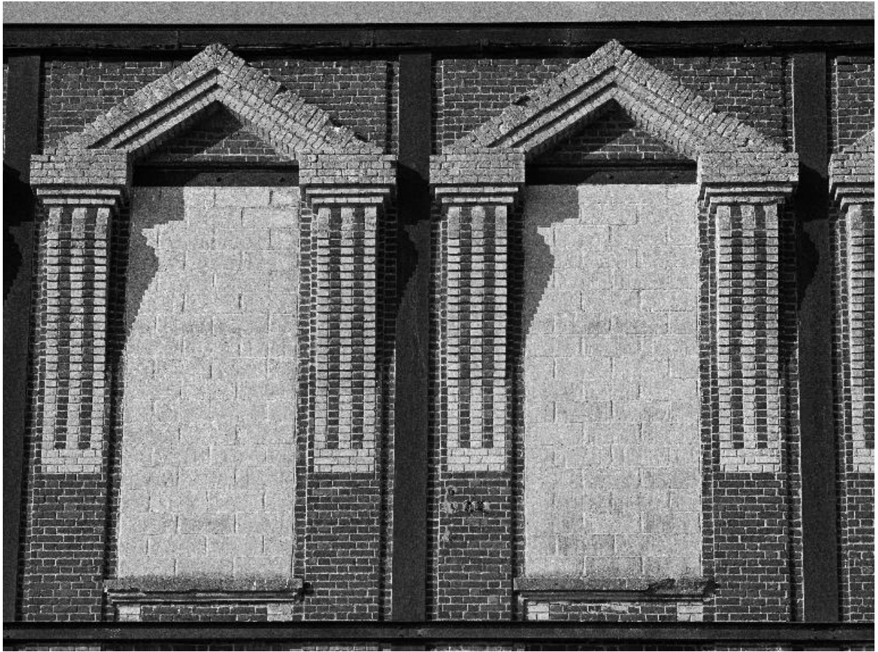
Atelier principal, flanc est.
