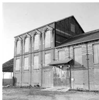
Atelier principal, flanc est. Détail. Phot. Francis Dubuc IVR22_19908001521X
