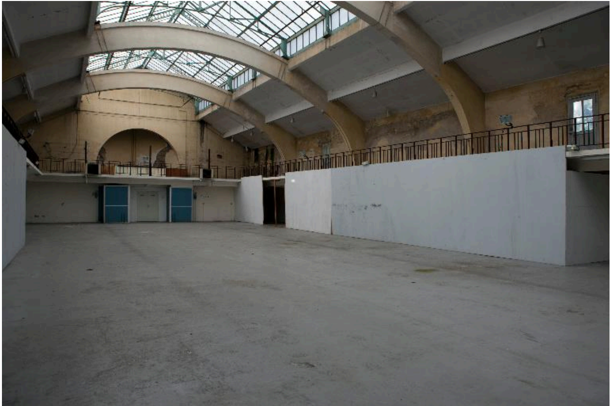
Vue générale de trois quarts de l'ancien bassin recouvert.
