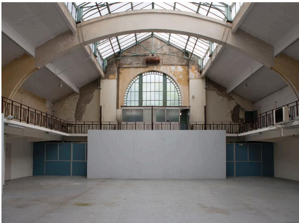
Vue générale de face de l'ancien bassin recouvert.
