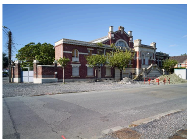
vue générale de la façade depuis l'avenue du Clos.
