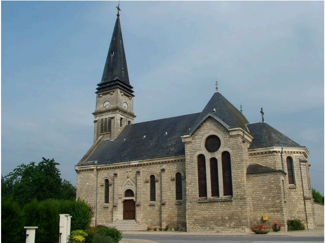
Vue latérale de l'église.
