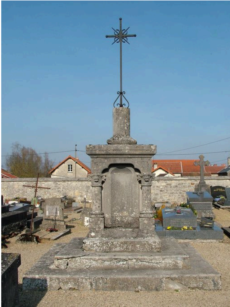
Croix monumentale située au centre du cimetière.
