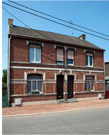
Vue générale de deux maisons jumelles rue G. Waxin. Phot. Pierre Thibaut IVR31_20125901772NUCA
