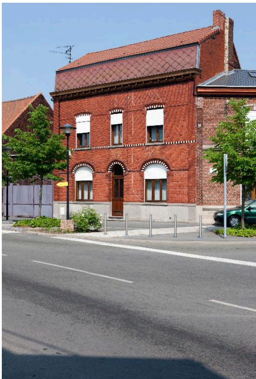
Une maison de bourg, rue de Fresnes.
