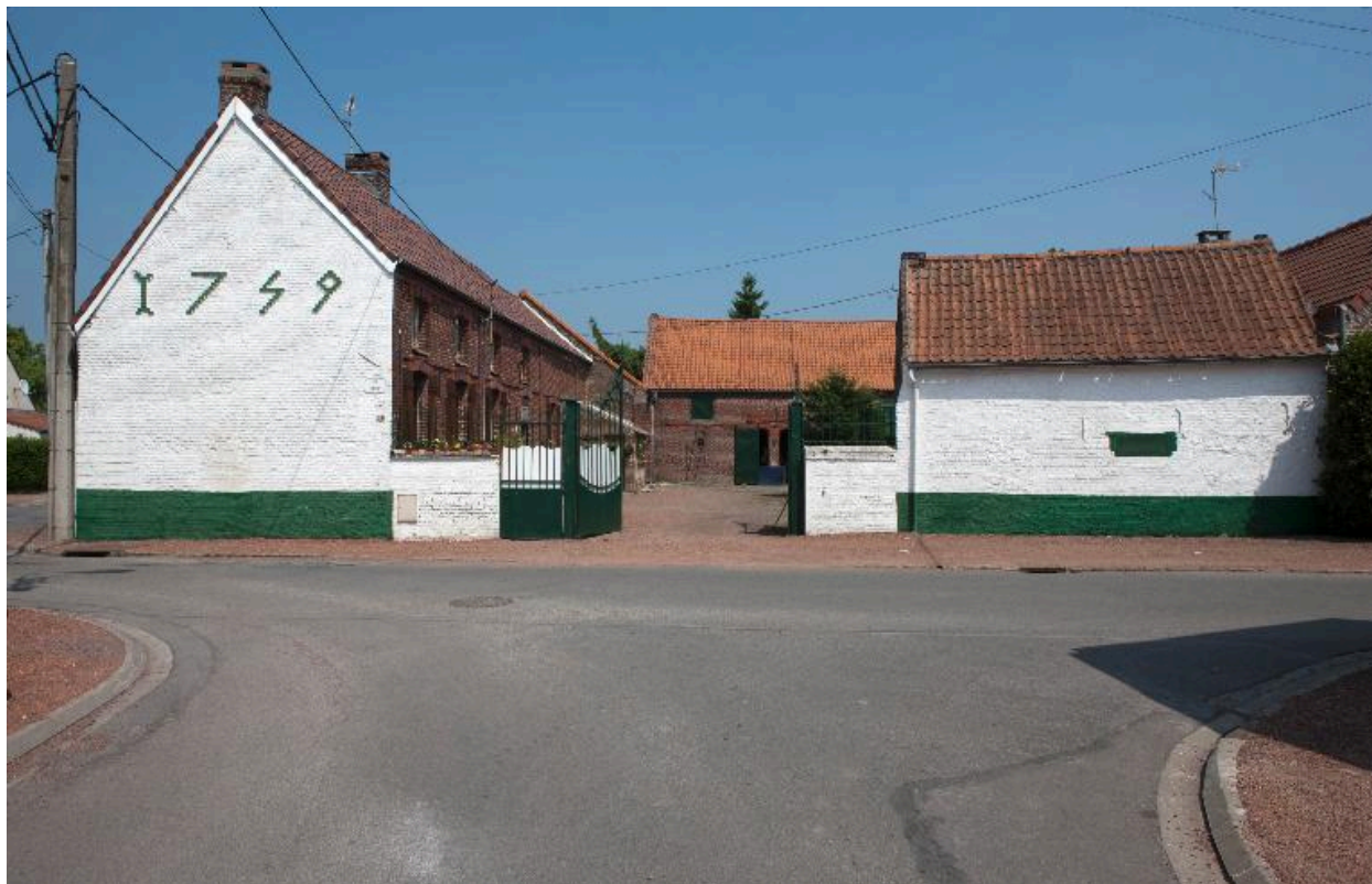
Vue générale d'une ferme à cour fermée, 34 rue Basse.
