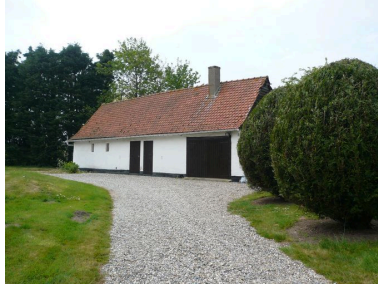
Vue des dépendances. Phot. Inès Guérin IVR22_20078005056NUCA
