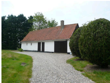
Vue des dépendances. Phot. Inès Guérin IVR22_20078005056NUCA
