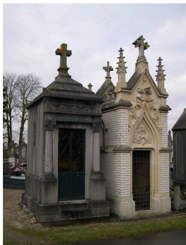
Vue de situation, tombeau à droite de l'image. Phot. Isabelle Barbedor IVR22_20058010065NUCA
