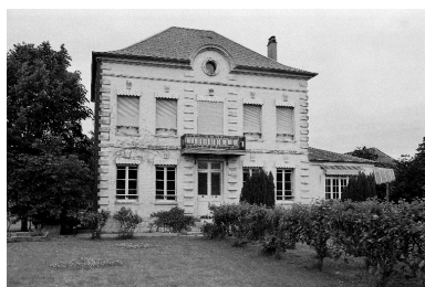
Logement patronal, élévation antérieure, en 1990. Phot. Francis Dubuc IVR22_19908000122Z
