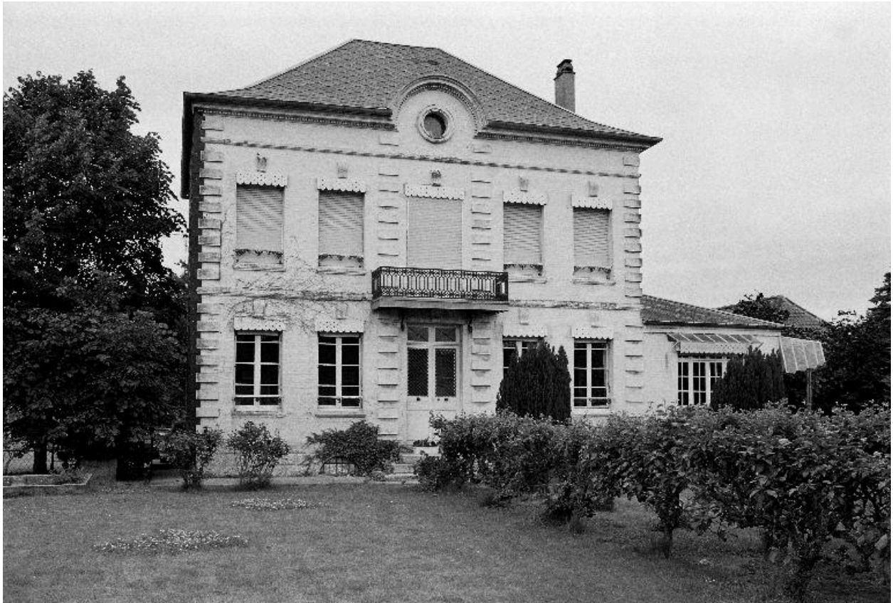
Logement patronal, élévation antérieure, en 1990.
