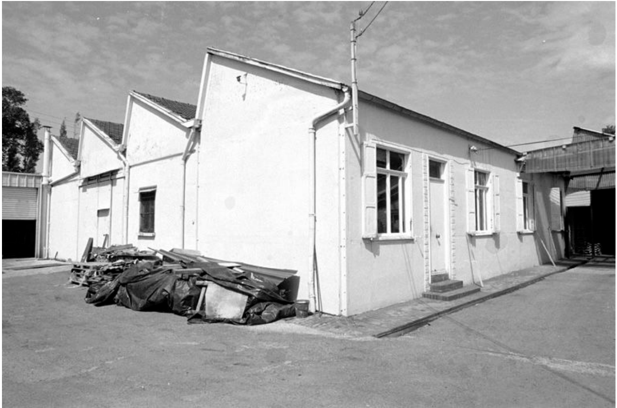
Atelier de fabrication, vue partielle, en 1990.
