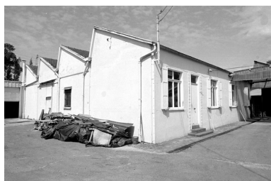
Atelier de fabrication, vue partielle, en 1990. Phot. Francis Dubuc IVR22_19908000105Z
