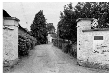
Le portail d'entrée du site, en 1990. Phot. Francis Dubuc IVR22_19908000123Z
