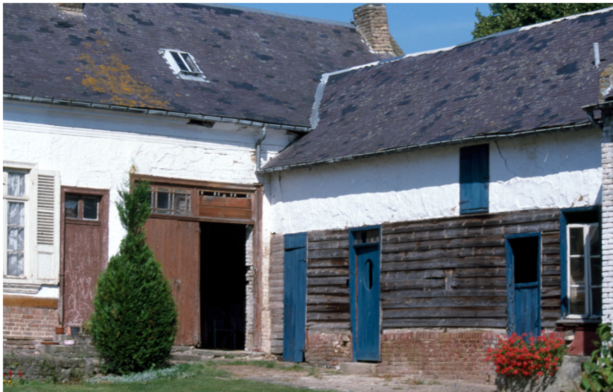
Vue des écuries au nord.
