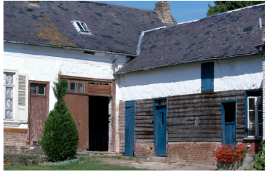
Vue des écuries au nord. Phot. Irwin Leullier IVR22_19998001603ZA
