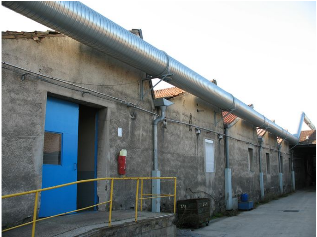
Détail des sheds.
