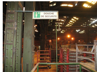
La douche de sécurité utilisée en cas d'accident. Elle est située à proximité des fours. Phot. Clarisse Lorieux IVR22_20066005081NUCA
