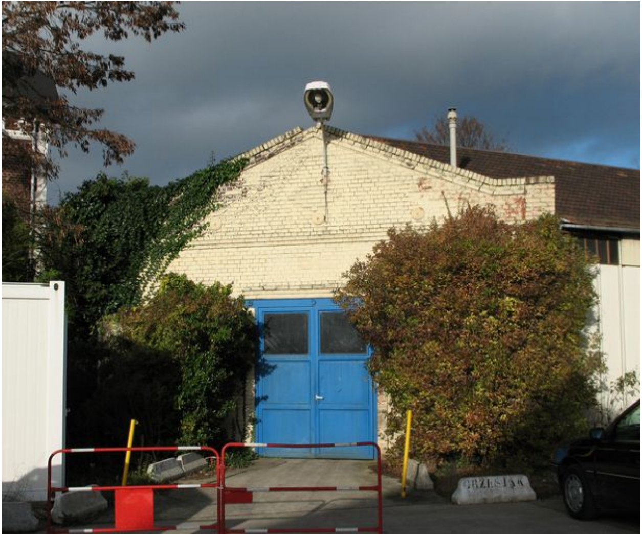
Bâtiment de la maintenance.
