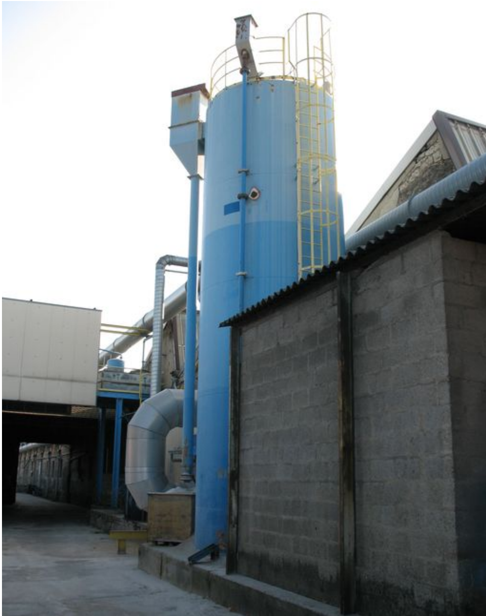
Silo de 60 tonnes pour stocker le sable servant à la fabrication des noyaux.
