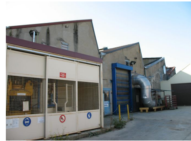
Ateliers de fabrication couverts en sheds. Phot. Clarisse Lorieux IVR22_20066005068NUCA
