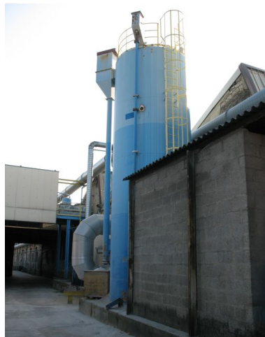
Silo de 60 tonnes pour stocker le sable servant à la fabrication des noyaux. Phot. Clarisse Lorieux IVR22_20066005069NUCA
