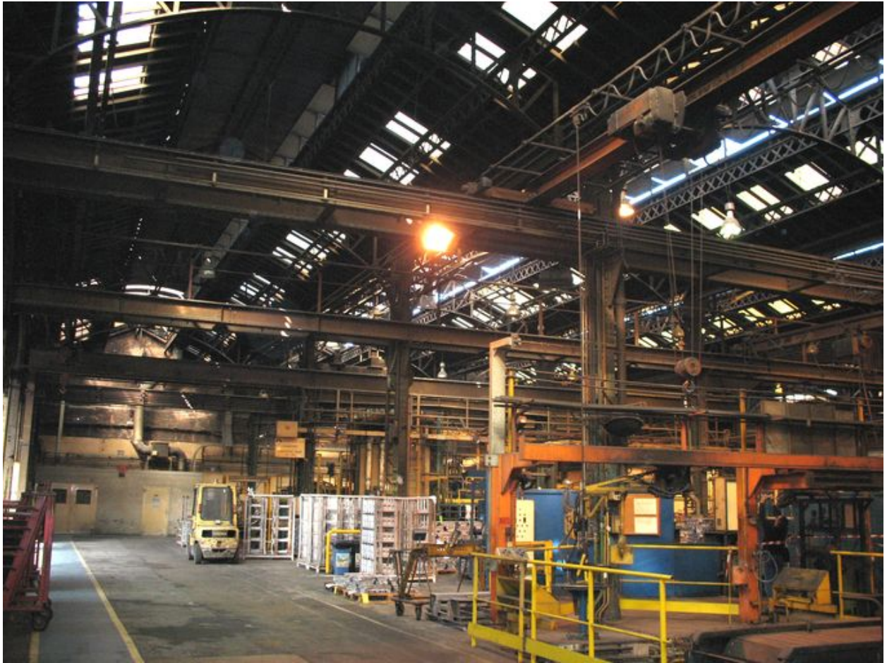
Intérieur des halles Eiffel.
