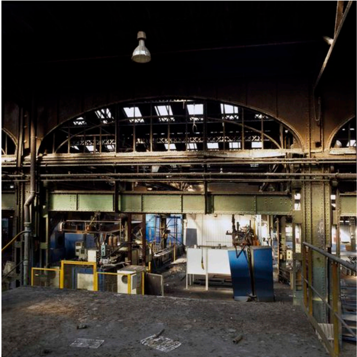
Détail de la structure.
