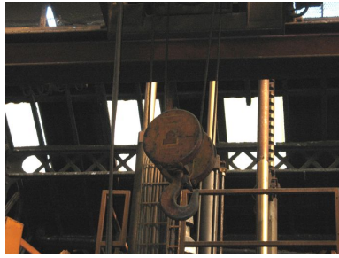
Treuil situé sous la halle. Phot. Clarisse Lorieux IVR22_20066005082NUCA
