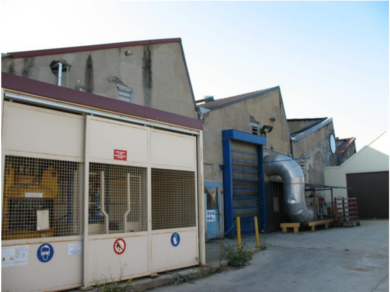
Ateliers de fabrication couverts en sheds.
