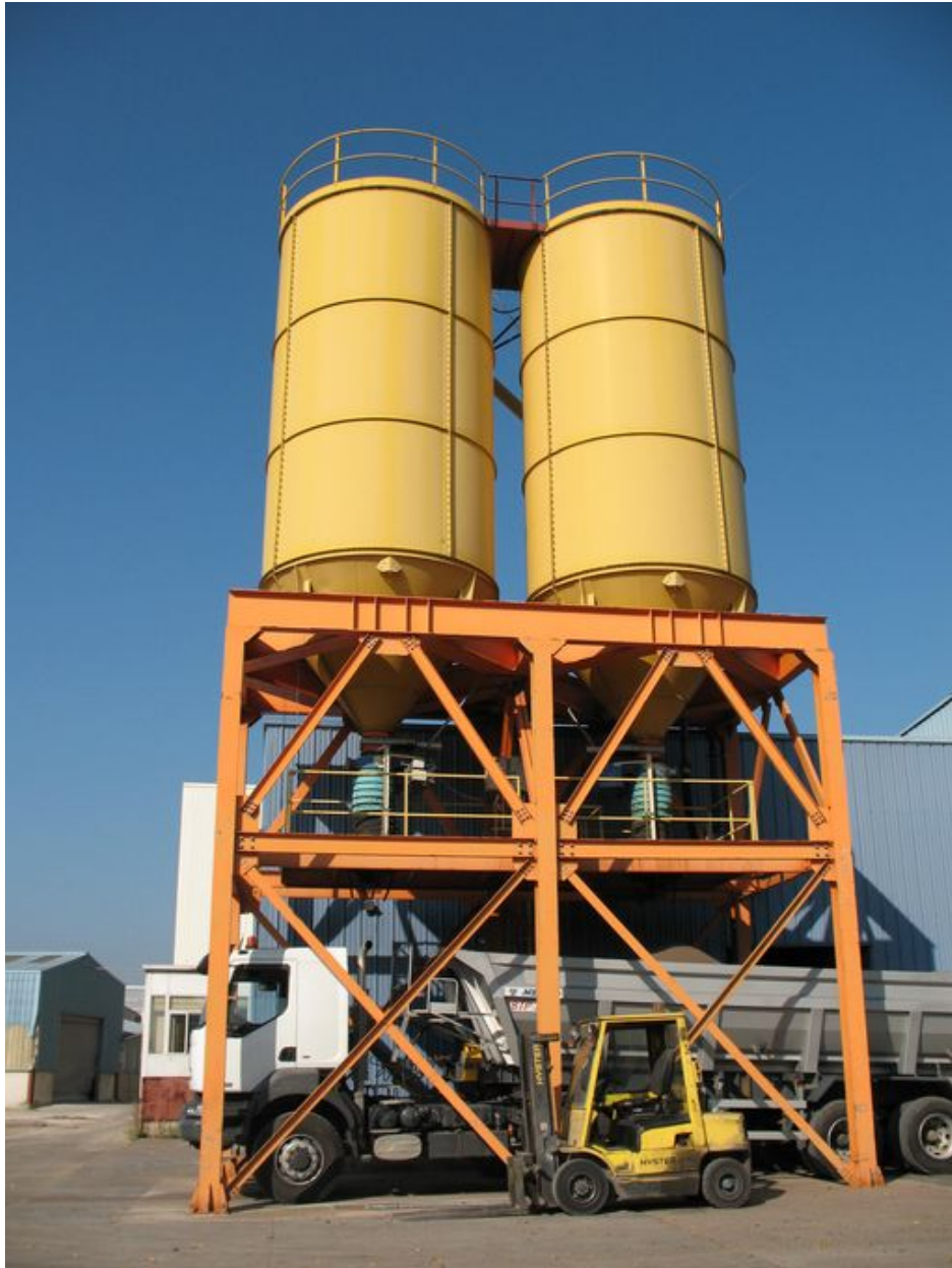
Silos contenant le sable recyclé après concassage et broyage et destiné aux tuileries.
