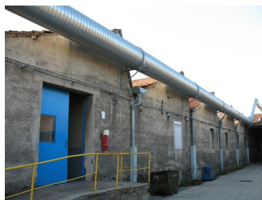
Détail des sheds. Phot. Clarisse Lorieux IVR22_20066005073NUCA
