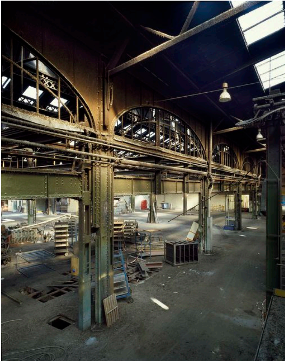
Structure Eiffel : détail d'une travée.
