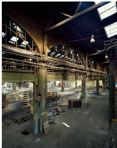
Structure Eiffel : détail d'une travée. Phot. Thierry Lefébure IVR22_20106000487VA
