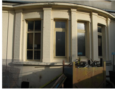
Détail des fenêtres du laboratoire. Phot. Clarisse Lorieux IVR22_20066005113NUCA
