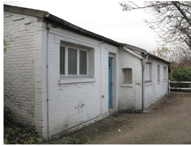
Atelier en brique construit en 1894 et attenant à la fonderie (détruite) de Pierre Montupet. Phot. Clarisse Lorieux IVR22_20086005249NUCA
