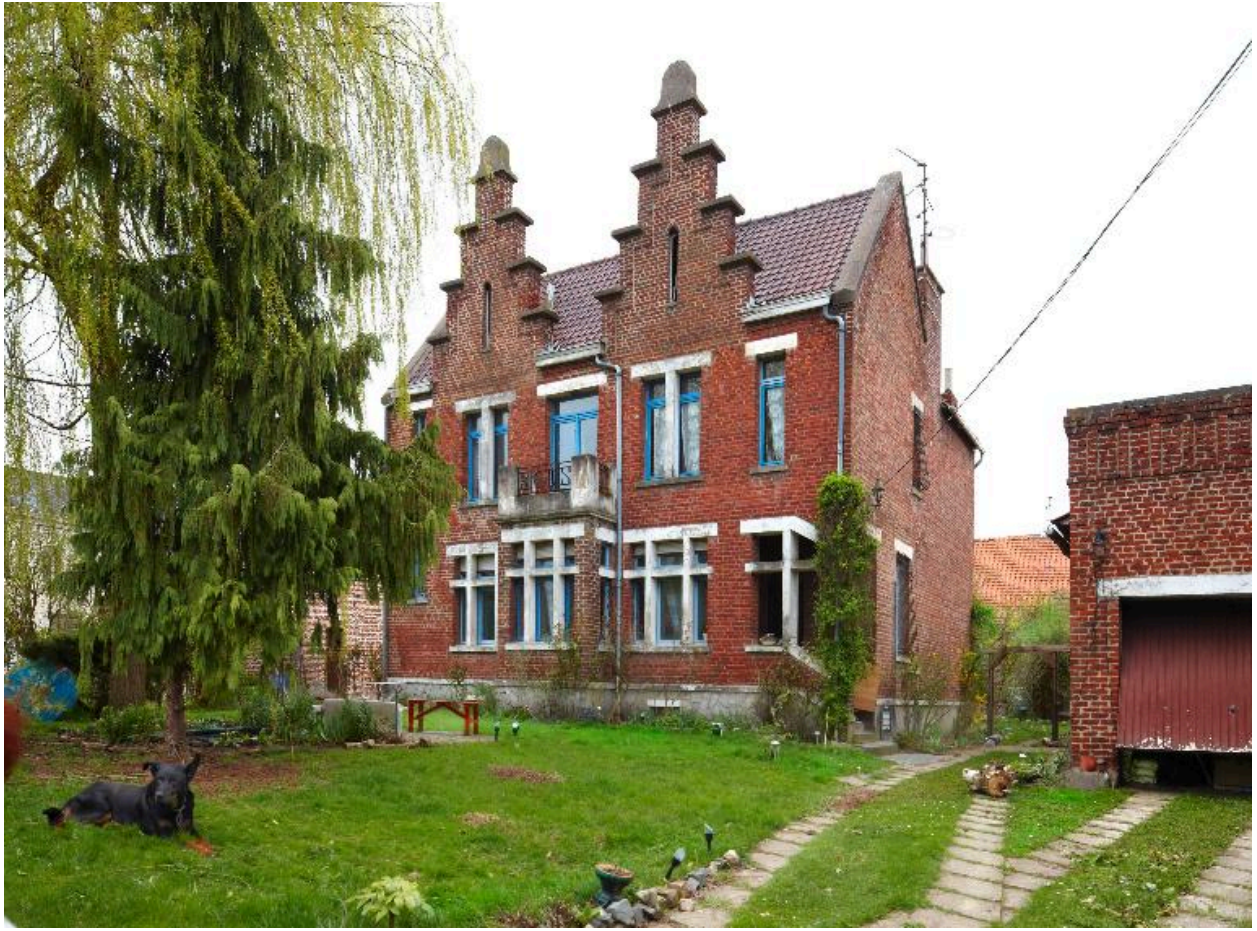
Maison au pignon à redent néoflamand, rue de Maulde.
