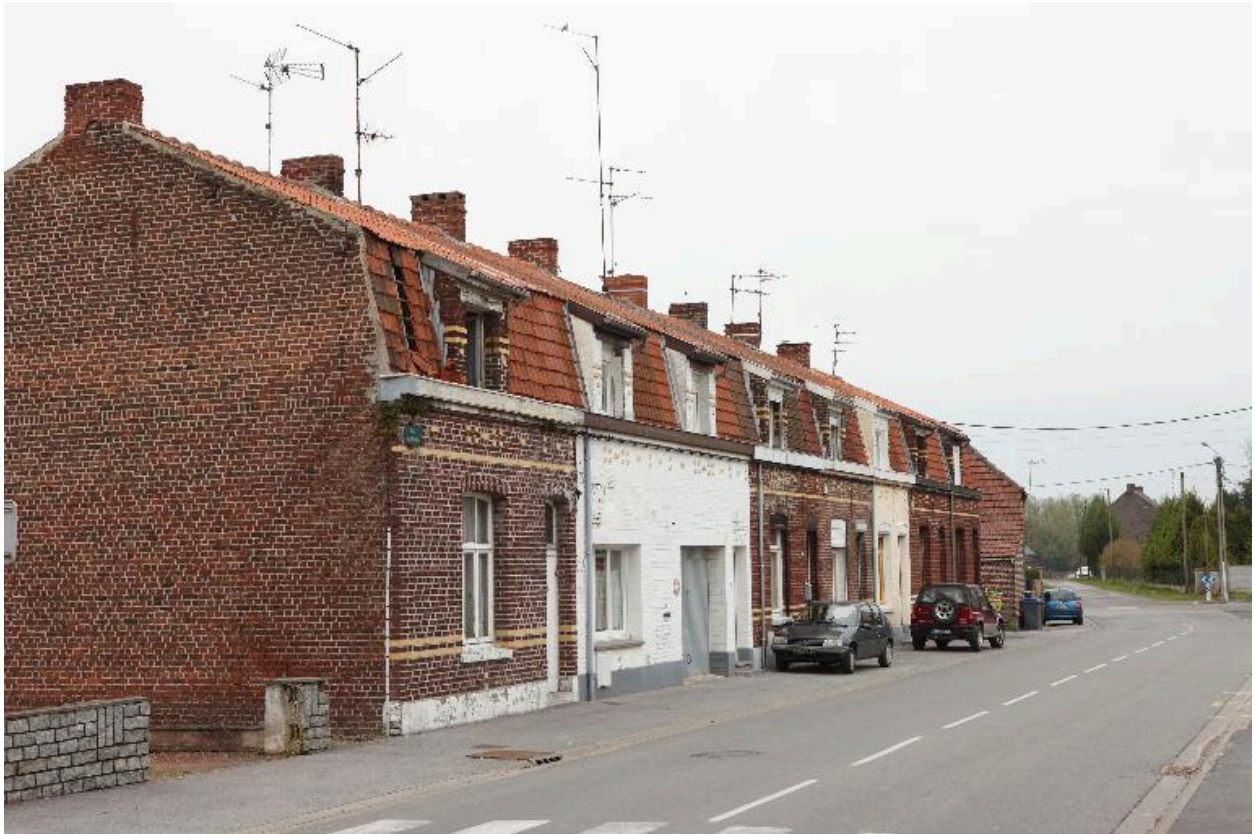
Maisons ouvrières en série, 22-36, rue de Maulde.
