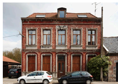
Maison, 59, rue Boeynaems. Phot. Hubert Bouvet IVR31_20105900138NUCA
