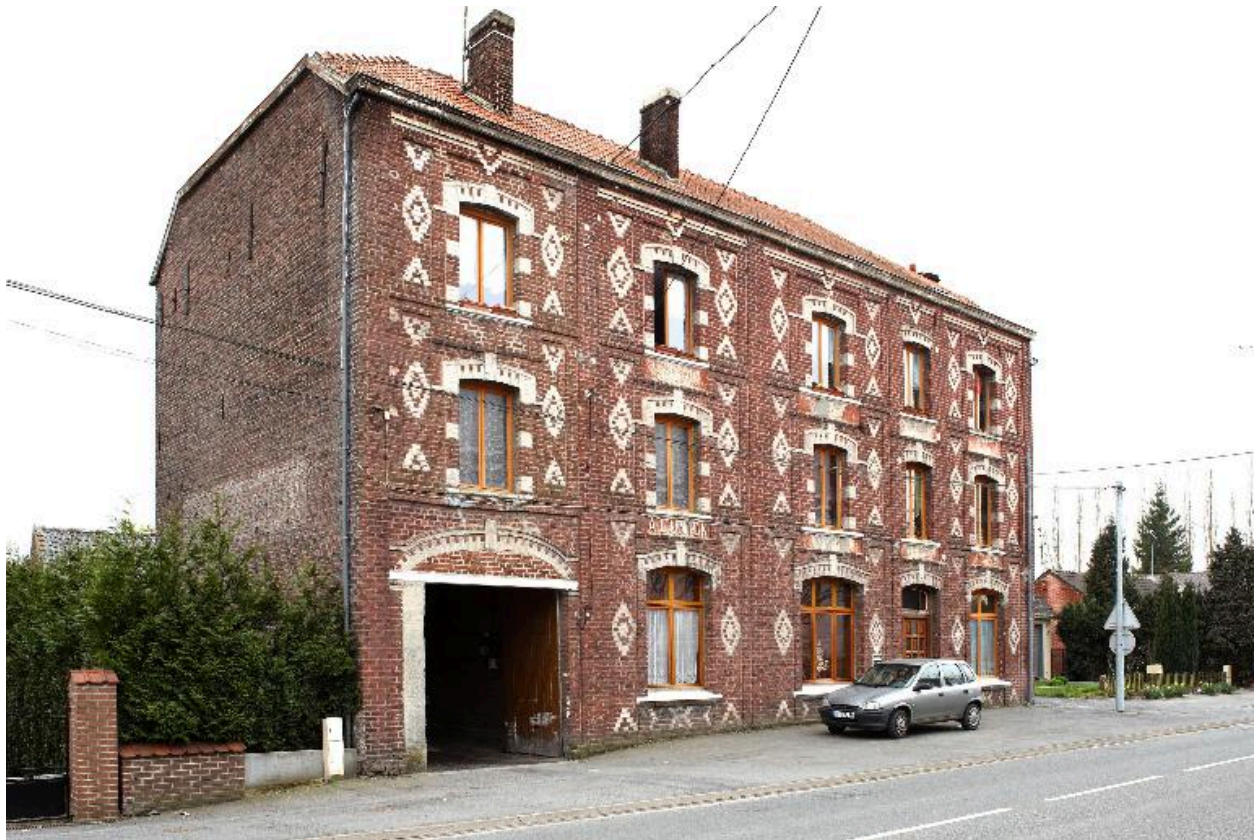
Immeuble A l'Union, ancien café-hôtel, 29, rue du Commandant Chaumonot.
