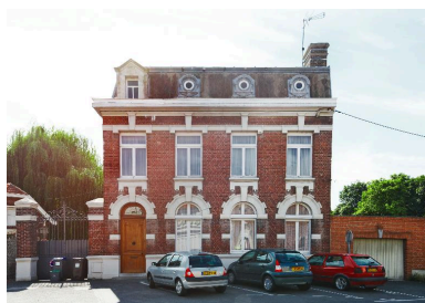
Maison bourgeoise, 21, rue du Fort. Phot. Hubert Bouvet IVR31_20105900664NUCA
