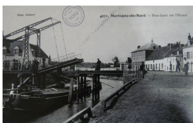
Le pont levis sur l'Escaut, début XXe siècle (collection particulière). Phot. Sophie Luchier IVR31_20085900514NUC
