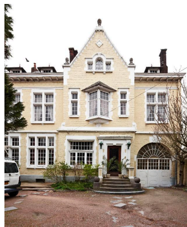
Maison bourgeoise datant du début du XXe siècle (?), 28, rue du Fort. Phot. Hubert Bouvet IVR31_20105900105NUCA
