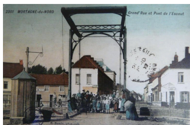
Le pont de l'Escaut et l'aubette, carte postale, début XXe siècle (collection particulière). Phot. Sophie Luchier IVR31_20085905013NUC
