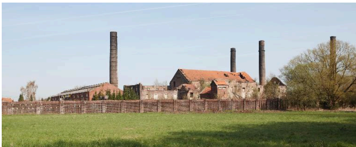
Vue générale de l'ancienne usine de produits réfractaires Escoyez.
