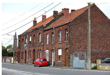
Maisons en série, 27-31 rue Fernig. Phot. Hubert Bouvet IVR31_20105900147NUCA
