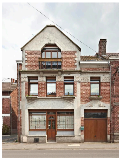
Maison, 27 rue Boeynaems. Phot. Hubert Bouvet IVR31_20105900142NUCA
