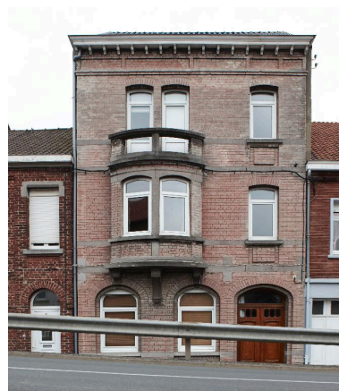
Maison-immeuble, 7, rue du Fort. Phot. Hubert Bouvet IVR31_20105900107NUCA
