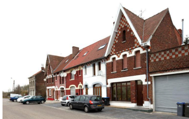
Maisons en série, Place de la gare. Phot. Hubert Bouvet IVR31_20105900098NUCA
