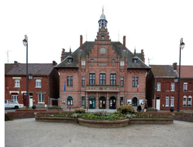
Vue générale de la mairie. Phot. Hubert Bouvet IVR31_20105900114NUCA
