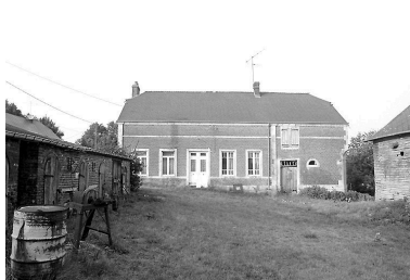
Élévation antérieure du logis. Phot. Xavier-Philippe Guiochon IVR22_19980203153Z
