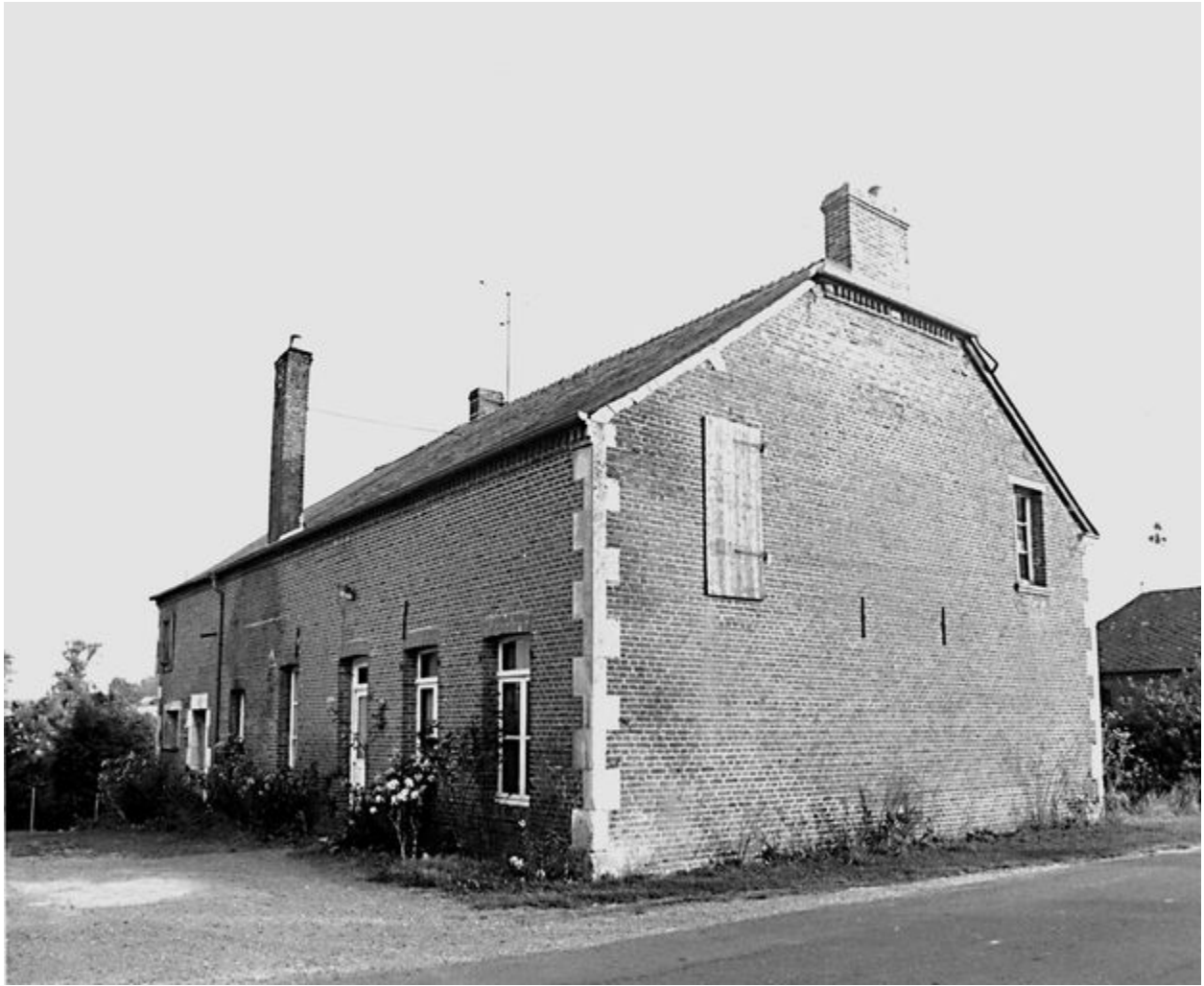
Elévation postérieure du logis.
