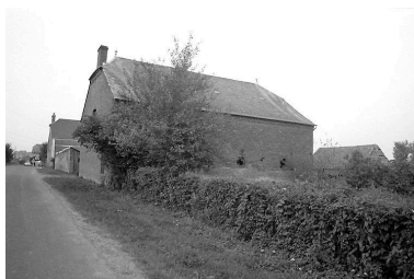
Élévation postérieure de l'étable. Phot. Xavier-Philippe Guiochon IVR22_19980203093Z
