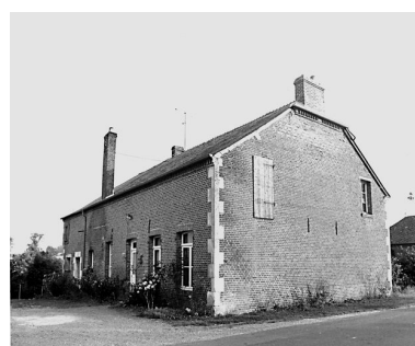
Élévation postérieure du logis. Phot. Xavier-Philippe Guiochon IVR22_19980203152Z
