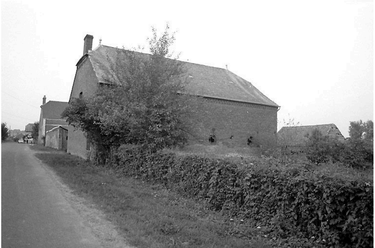
Elévation postérieure de l'étable.
