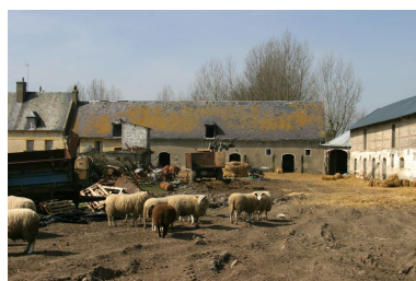
Vue sur l'angle nord-ouest de l'ensemble depuis l'intérieur de la cour.
