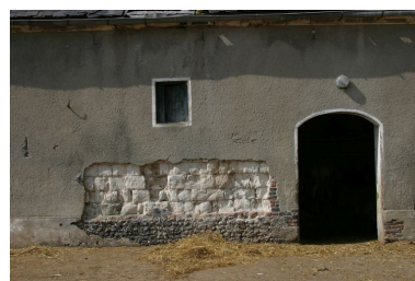
Détail de la maçonnerie de ce bâtiment.
