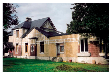
Façade postérieure. Phot. Gilles-Henri Bailly IVR22_20158005603NUCA
