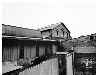
Atelier de fabrication, vue partielle.
