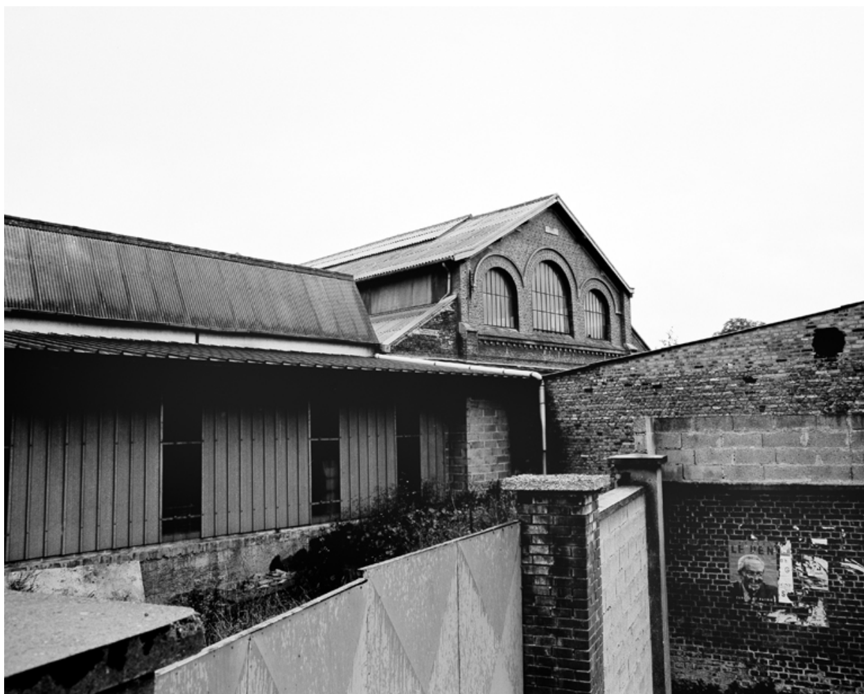
Atelier de fabrication, vue partielle.
