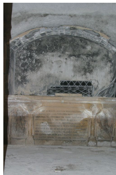
Vue de l'enfeu et de la plaque funéraire dans la crypte. Phot. Inès Guérin IVR22_20050200523NUCA
