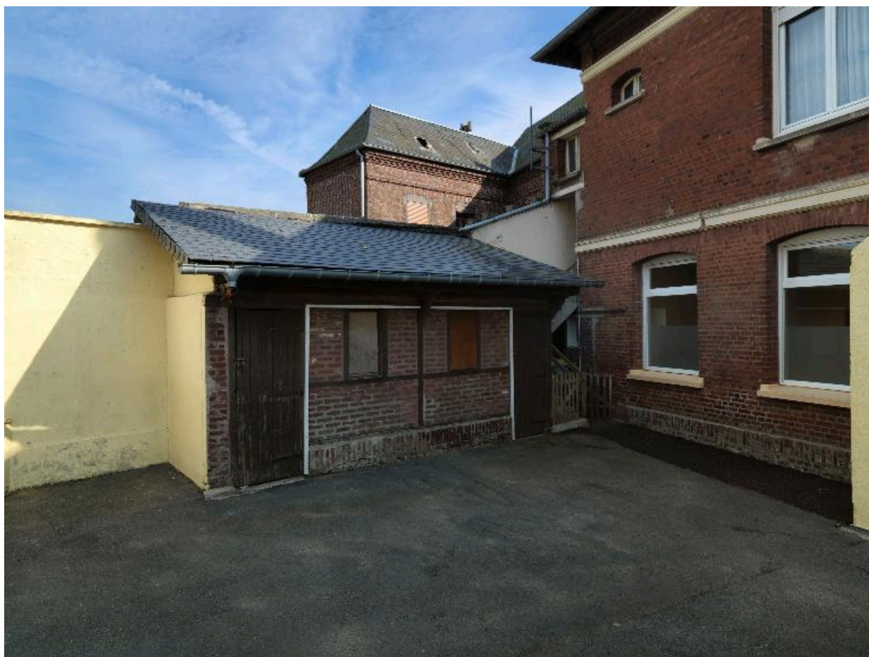
Vue des anciens cabinets d'aisance.
