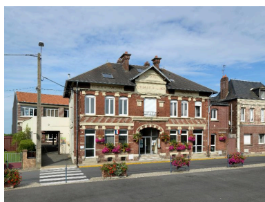
Vue générale depuis la place de l'église. Phot. Thierry Lefébure IVR22_20148000519NUC2A
