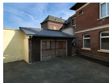
Vue des anciens cabinets d'aisance. Phot. Thierry Lefébure IVR22_20148000521NUC2A
