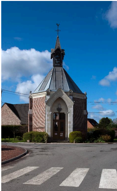
Vue générale. Phot. Pierre Thibaut IVR31_20125901603NUCA
