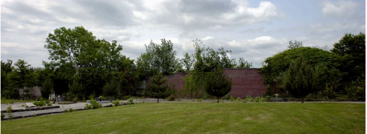
Vue de situation des concessions adossées au mur ouest du cimetière.
