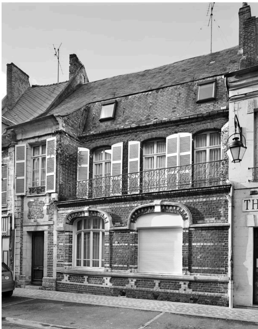
Vue de la façade sur rue.
