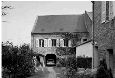
Vue de la remise, au fond de la cour. Phot. Thierry Lefébure IVR22_19990202209X
