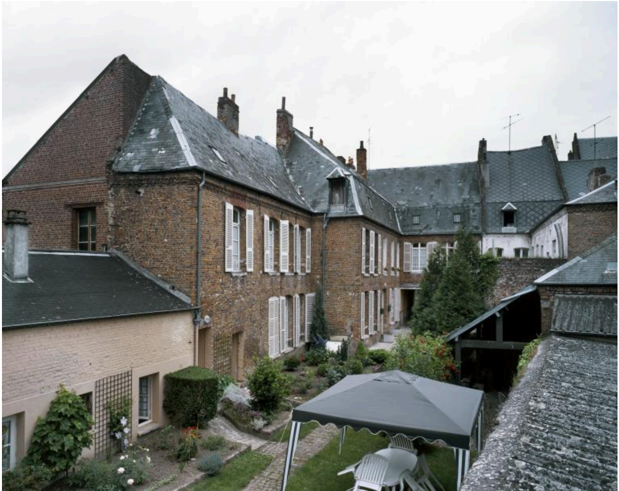
Vue des façades sur cour.
