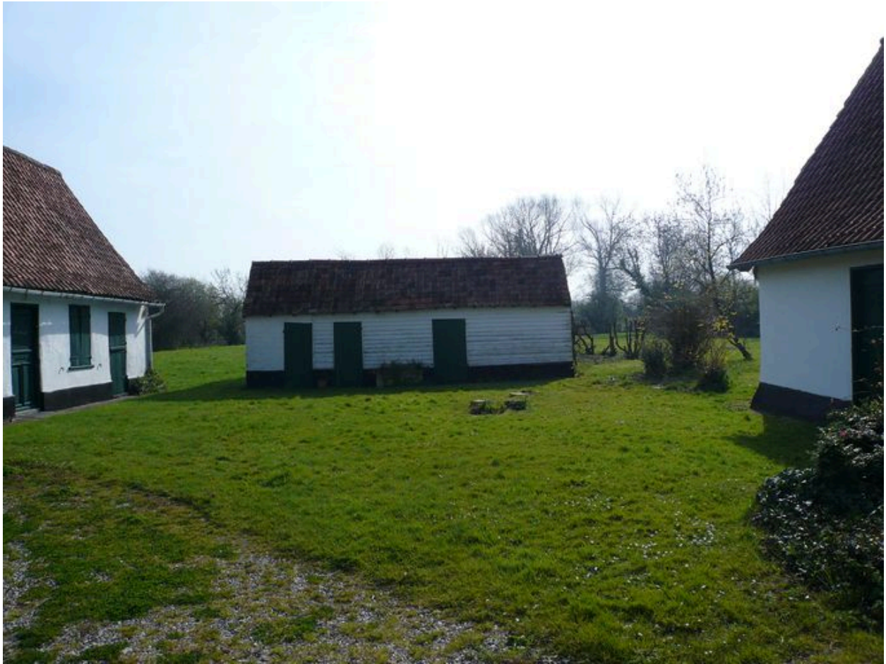
Vue des porcheries à l'est de la cour.
