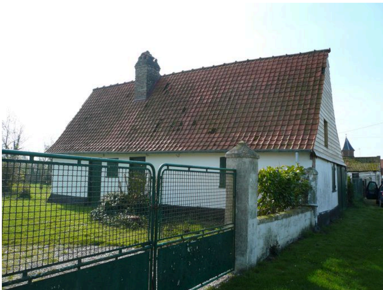
Vue des étables au sud.
