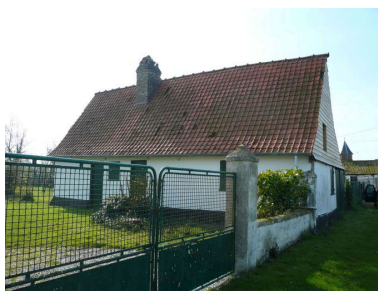
Vue des étables au sud.
