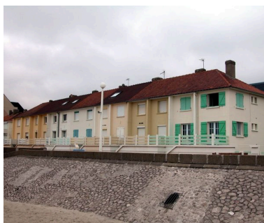
Vue d'ensemble des façades côté mer. Phot. Elisabeth Justome IVR22_20058003264NUCA
