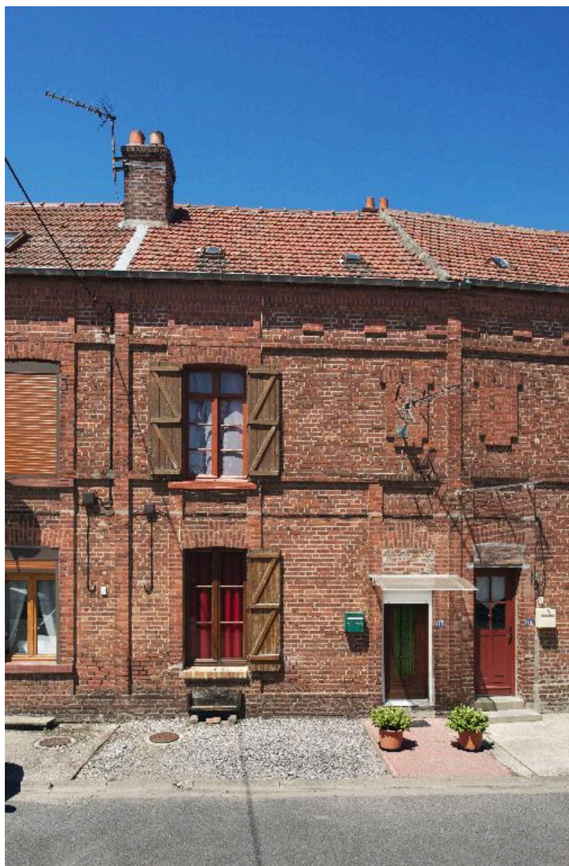
Détail du logement n°13 de l'impasse Gabriel-Péri.
