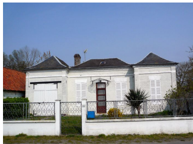
Vue générale. Phot. Inès Guérin IVR22_20078005700NUCA
