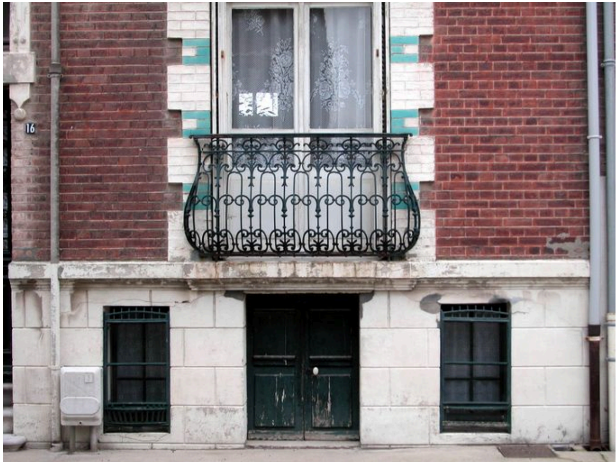
Détail d'un des sous-sol semi-enterré avec accès en façade.
