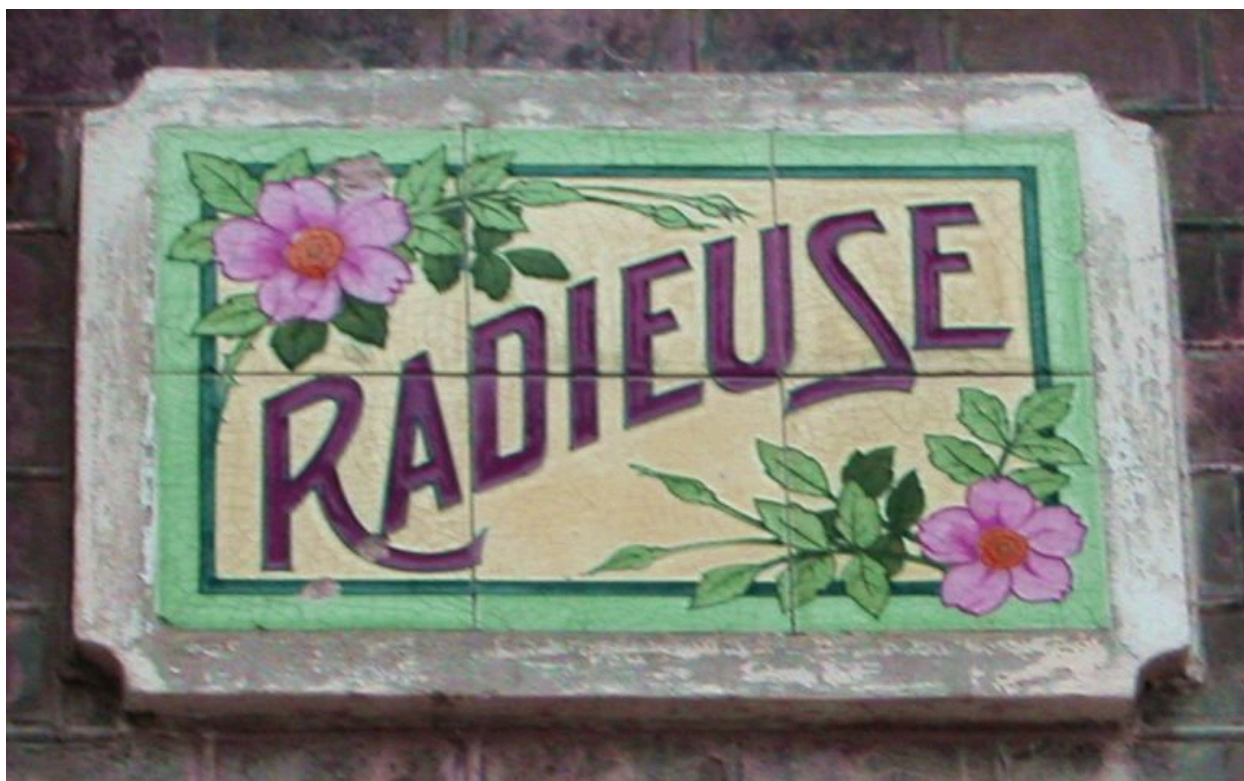
Détail des carreaux de céramique portant appellation 'Radieuse'.
