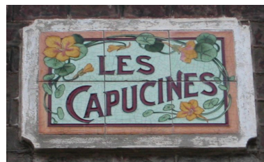
Détail des carreaux de céramique portant appellation 'Les Capucines'. Phot. Elisabeth Justome IVR22_20058002515NUCA
