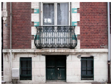
Détail d'un des sous-sol semi-enterré avec accès en façade. Phot. Elisabeth Justome IVR22_20058002514NUCA
