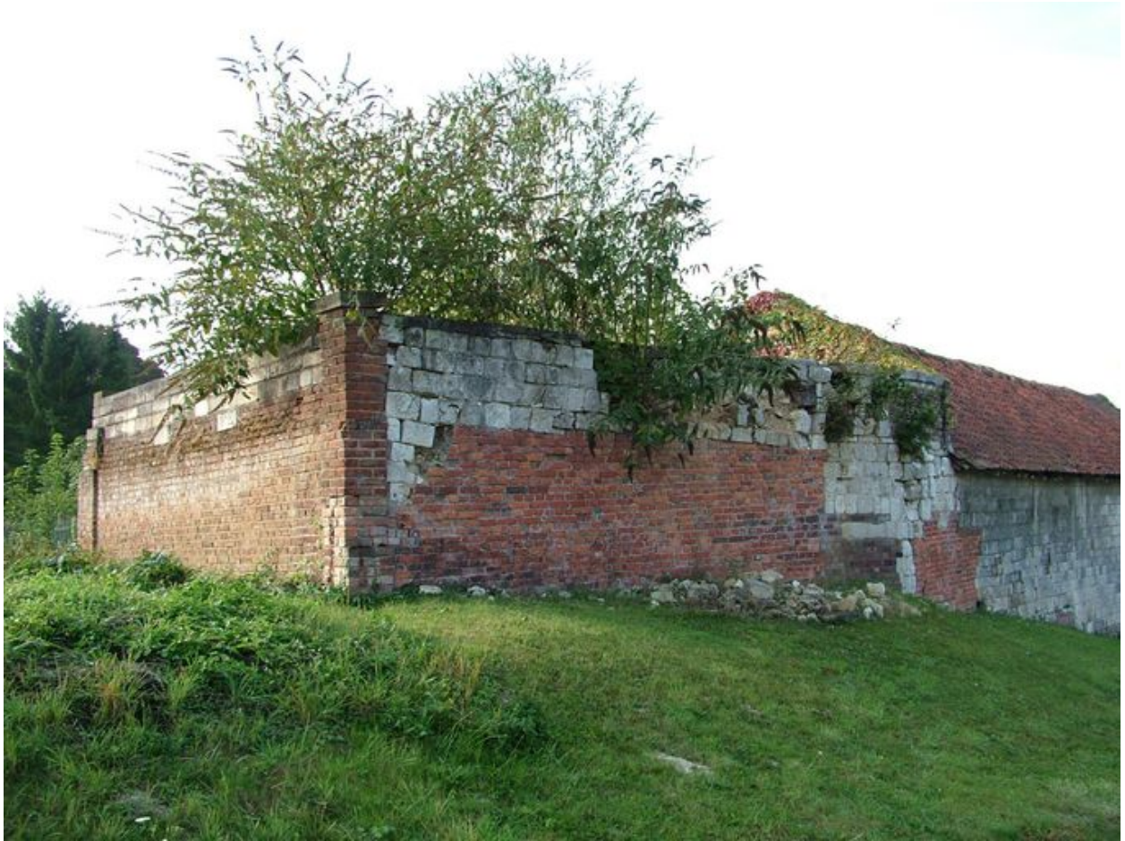
Vestiges de l'ancien corps d'entrée.
