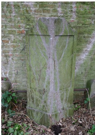
Pilier à deux pans. Phot. Caroline Vincent IVR22_20078000304NUCA
