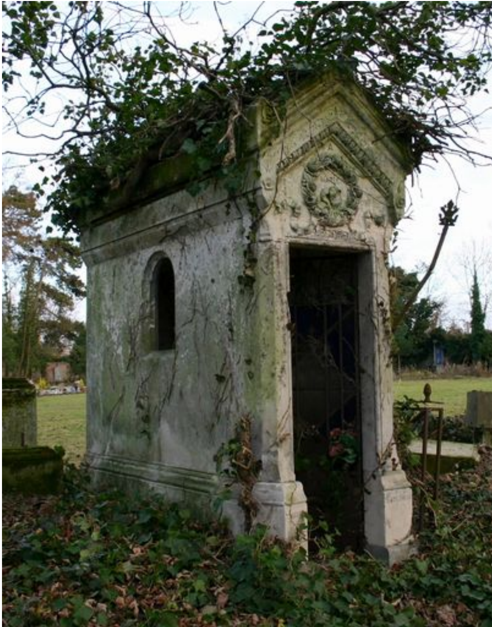
Vue générale, depuis le côté.
