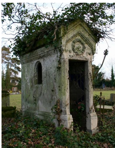
Vue générale, depuis le côté.
