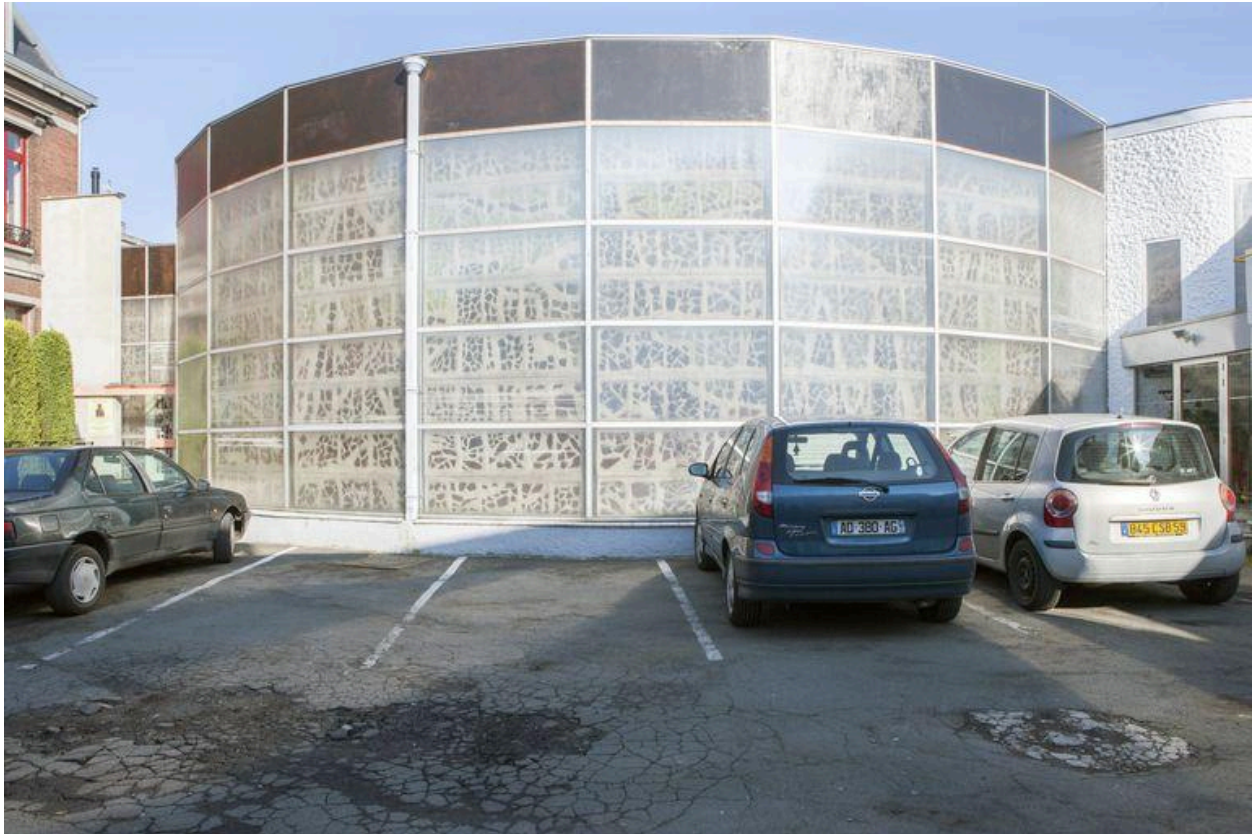
Vue du flanc droit de la chapelle depuis l'extérieure.
