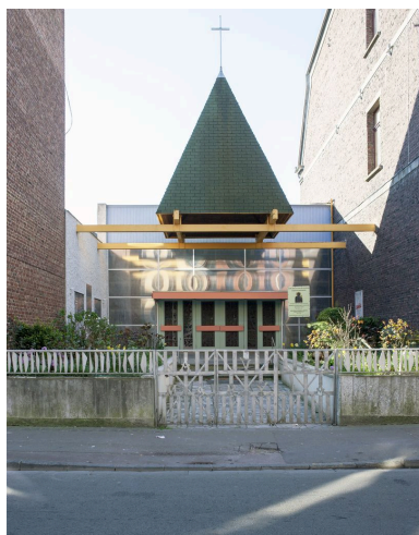
Élévation antérieure de la chapelle. Phot. Pierre Thibaut IVR31_20155900880NUCA
