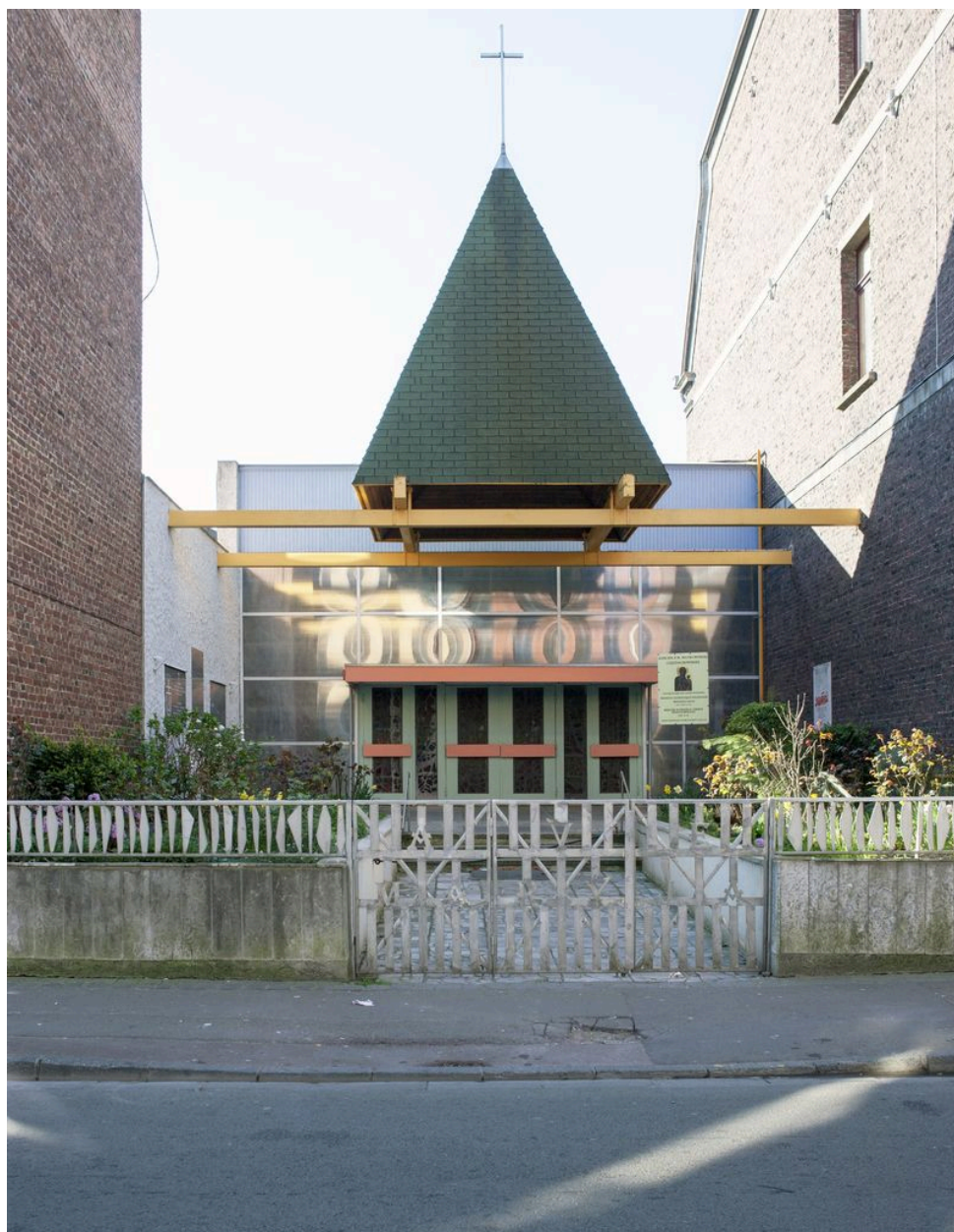
Élévation antérieure de la chapelle.
