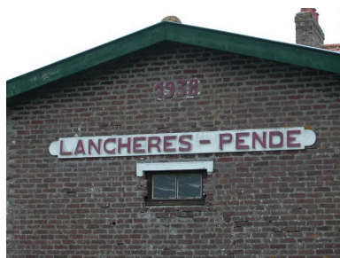
Détail porté sur le bâtiment principal de la gare de Lanchères. Phot. Elisabeth Justome IVR22_20038005436NUCA
