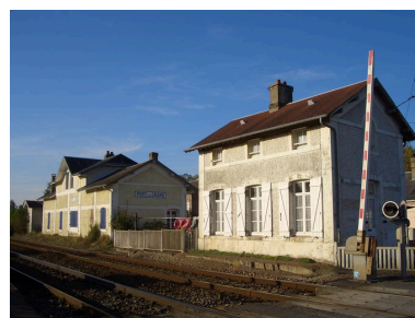
L'ancienne gare de Port-le-Grand. Phot. Inès Guérin IVR22_20068005474NUCA
