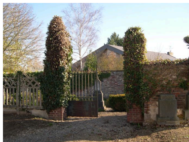
Vue du portail donnant accès à l'enclos. Phot. Isabelle Barbedor IVR22_20078010597NUCA
