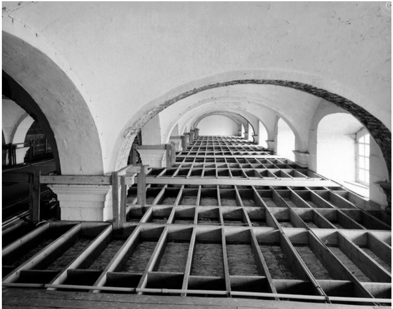
Corps de bâtiment fermant le flanc droit de la cour d'honneur, 1er étage, détail du voûtement des salles de cet étage, vue prise dans l'espace situé au-dessus des faux plafonds actuels.
