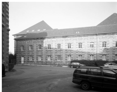
Cour des insensés, bâtiment de tracé en L, fermant le fond de la cour, qui abritait originellement les loges des insensés, branche longue du L, élévation sur cour.
