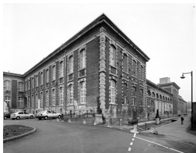
Elévation latérale droite donnant sur le canal de l'Escaut et élévation antérieure du corps de bâtiment fermant la cour des services sur l'avant, vue d'ensemble.
