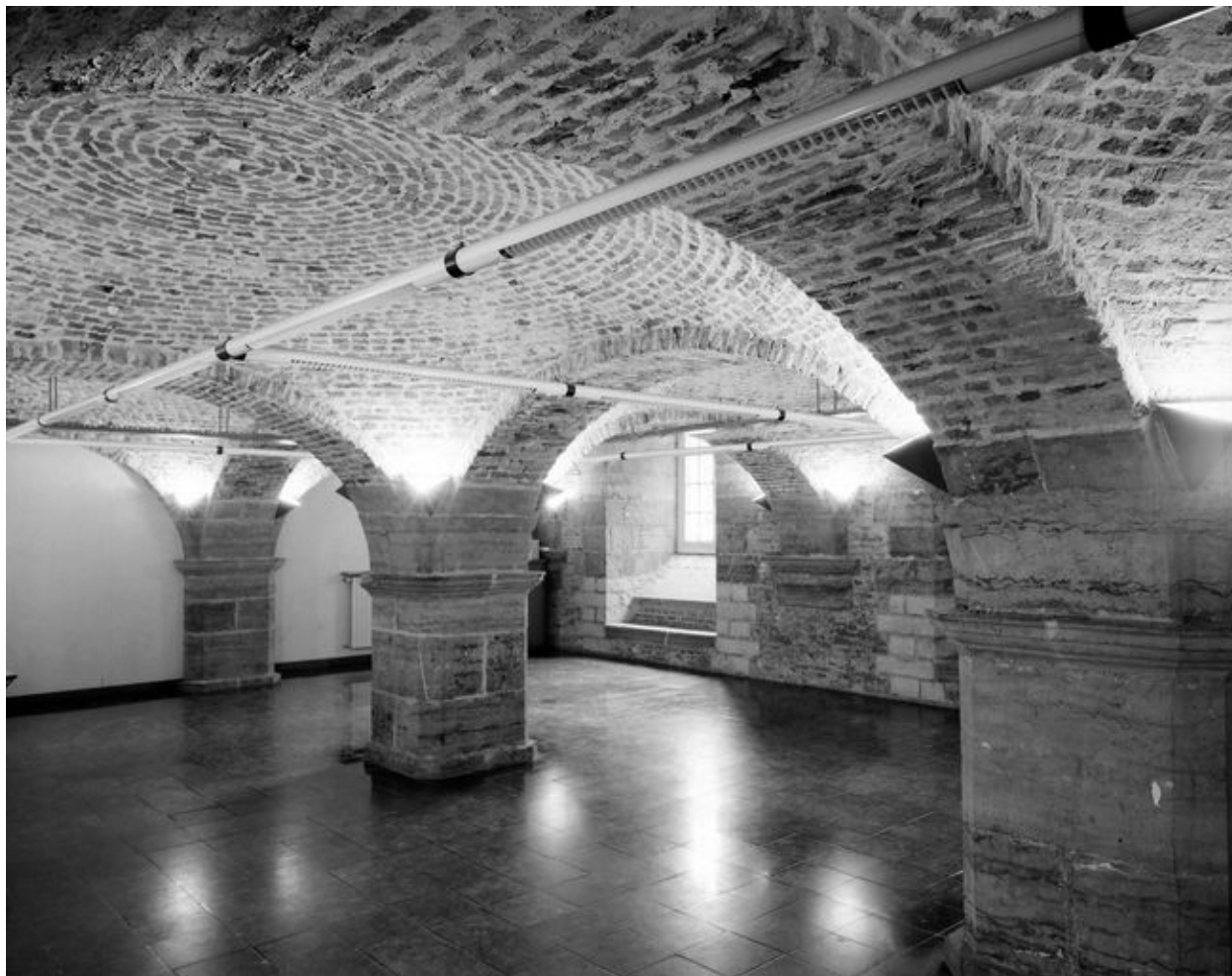
Corps de bâtiment fermant l'avant de la cour d'honneur, sous-sol, salle située sur le côté droit par rapport au passage d'entrée, vue générale,
