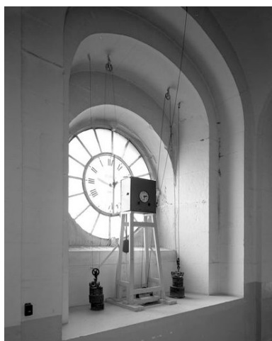
Corps de bâtiment fermant le fond de la cour d'honneur, 1er étage, galerie de distribution, ouverture correspondant au revers de l'horloge incluse au-dessus de la porte de la chapelle.
