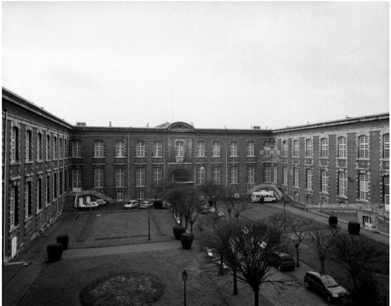
Cour d'honneur, vue générale en regardant vers le corps de bâtiment fermant la cour sur l'avant.
