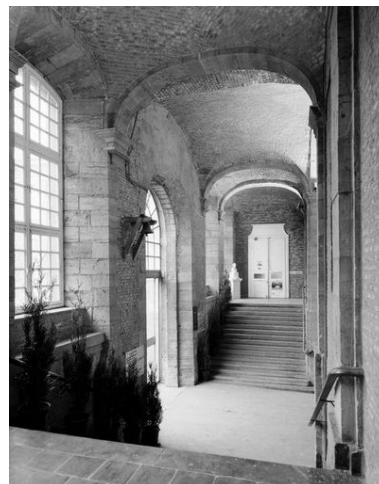
Corps de bâtiment fermant la cour d'honneur sur l'avant, passage d'entrée, escalier d'accès au rez-de-chaussée surélevé, vue générale prise du palier de la montée située à gauche en entrant.
