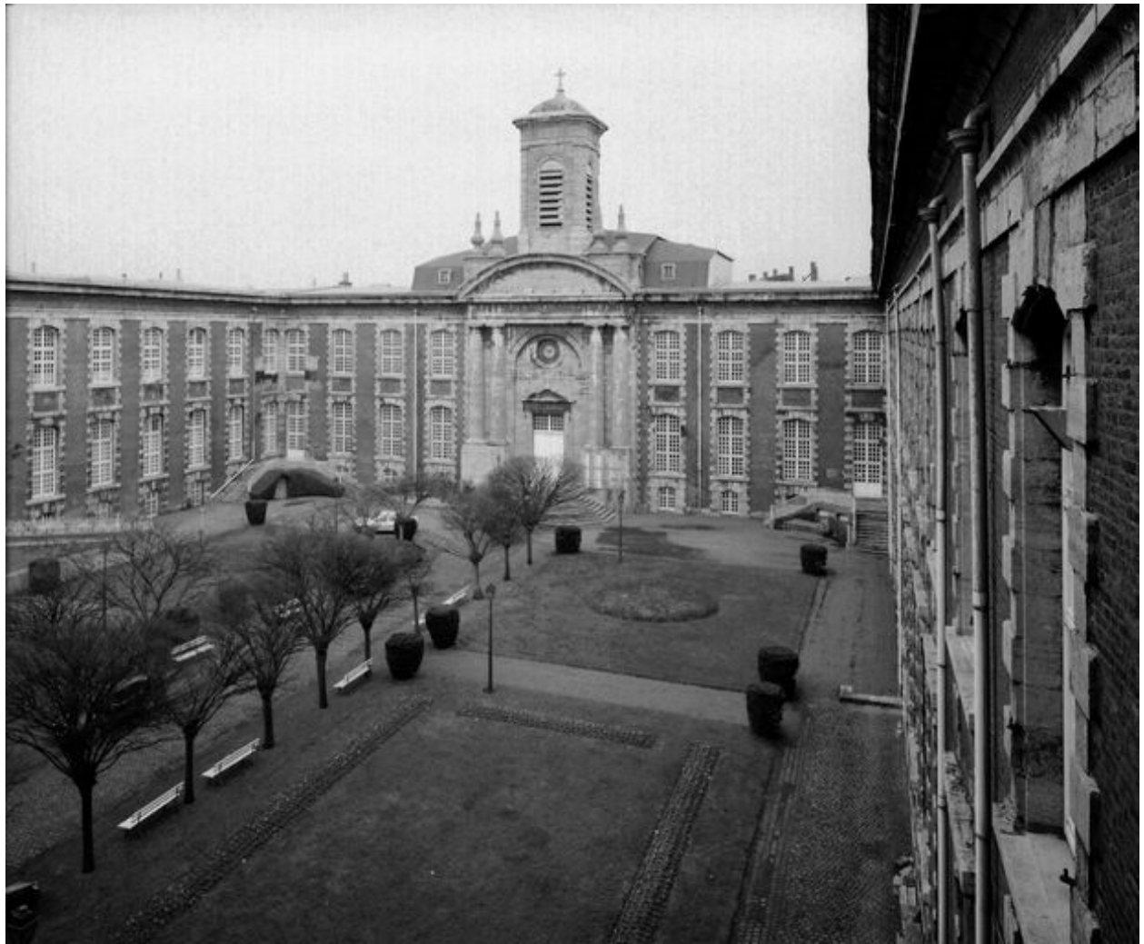
Cour d'honneur, vue générale en regardant vers le corps de bâtiment fermant le fond de la cour avec, au centre, la façade de la chapelle.
