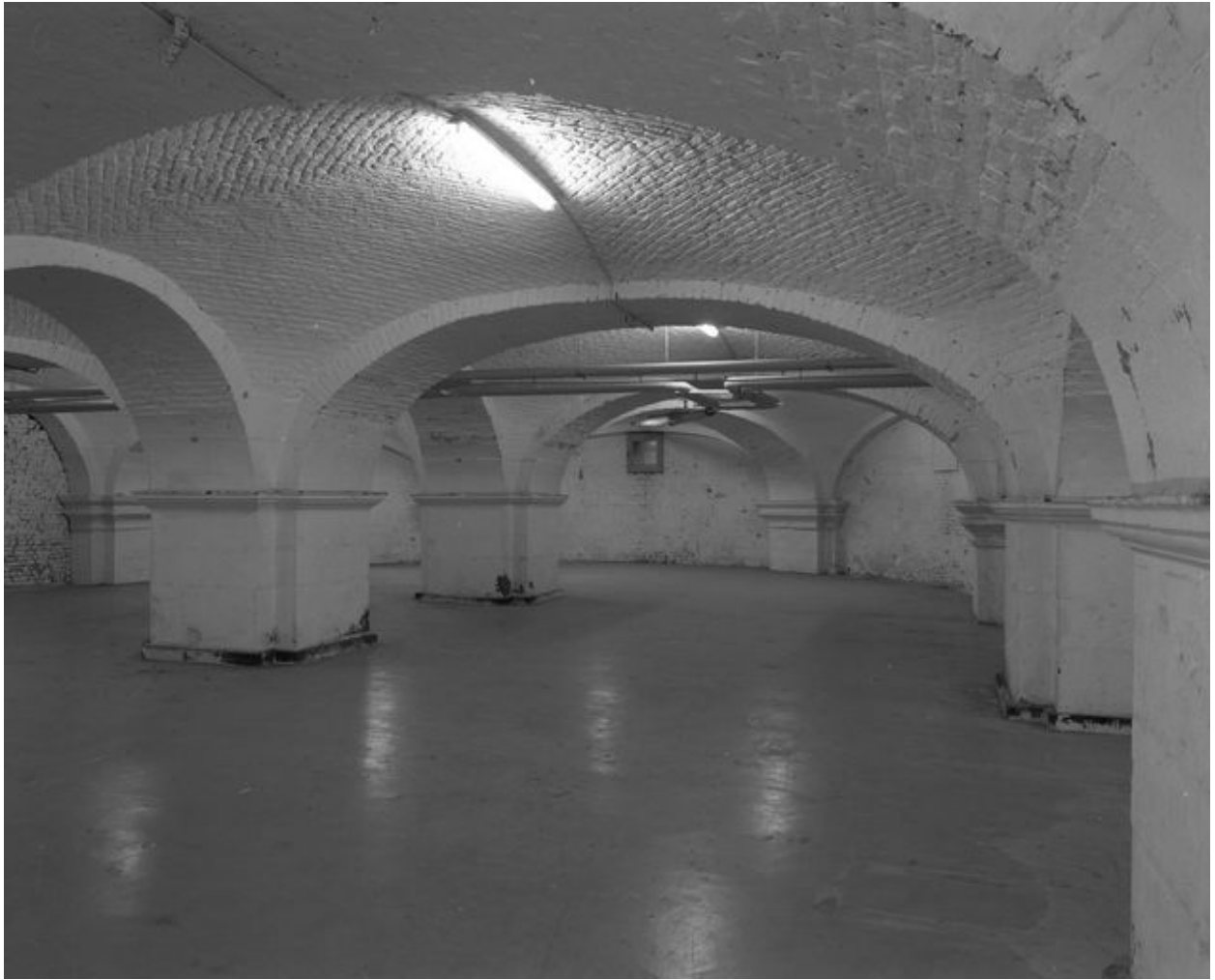
Corps de bâtiment fermant le fond de la cour d'honneur, sous-sol, salle à abside située au-dessous de la chapelle, vue générale.
