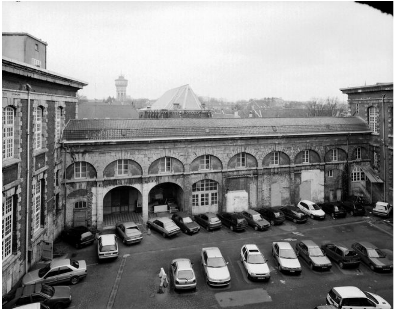
Cour des services, vue générale en regardant vers le corps de bâtiment fermant la cour sur son flanc droit.
