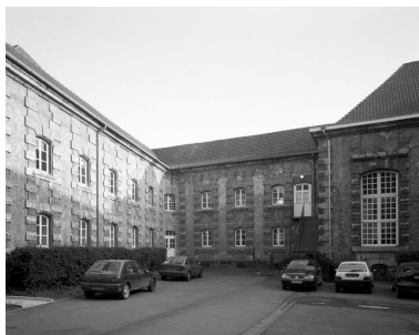
Cour des insensés, bâtiment de tracé en L, fermant le fond de la cour, qui abritait originellement les loges des insensés, élévation sur cour de la branche courte du L et de sa rencontre avec la branche longue.
