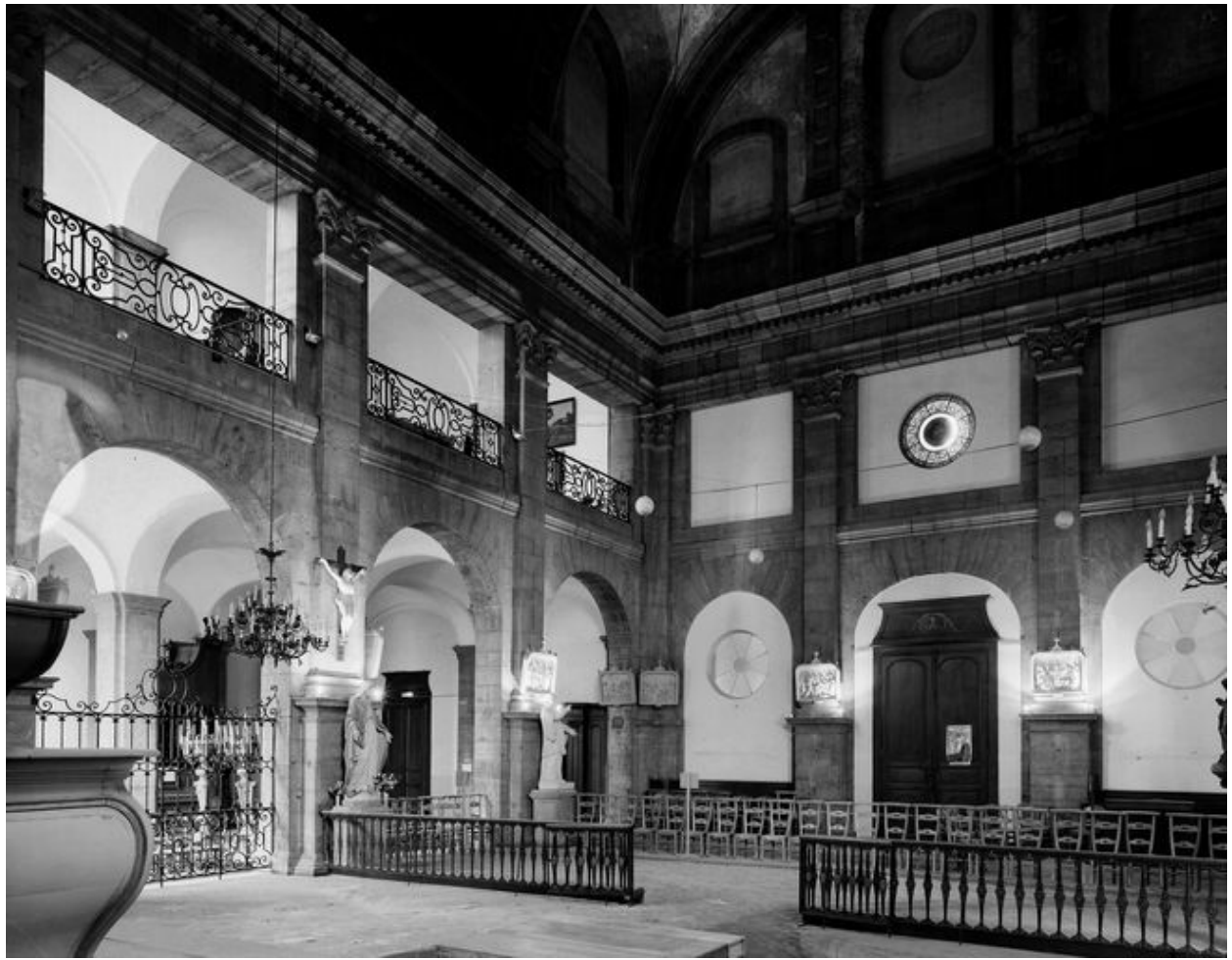
Corps de bâtiment fermant le fond de la cour d'honneur, rez-de-chaussée, chapelle, vaisseau central, vue générale en regardant vers l'angle des élévations intérieures sud et ouest
