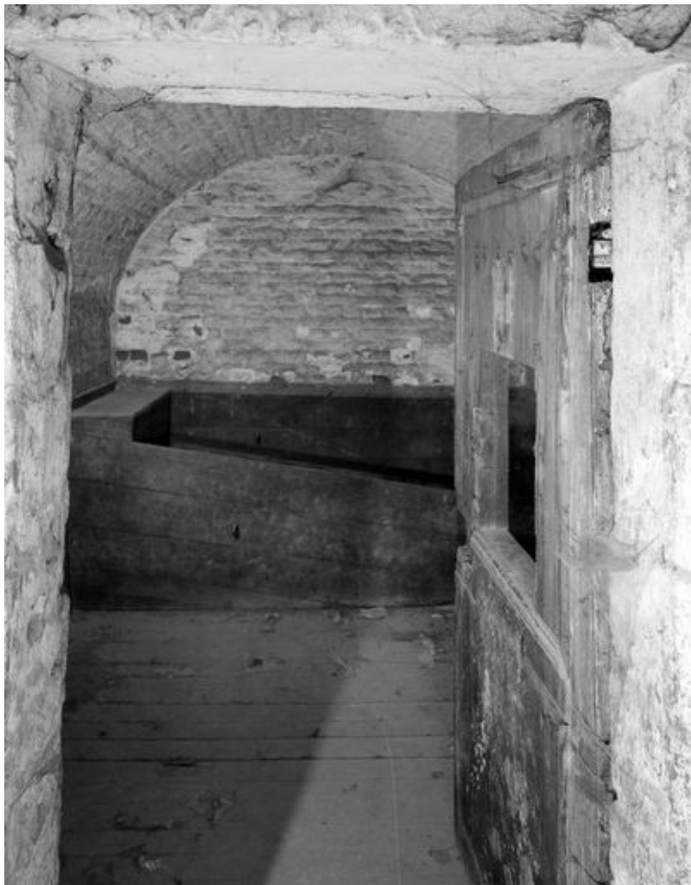
Bâtiment fermant le fond de la cour des insensés, qui abritait primitivement les loges de ces insensés, sous-sol destiné à l'origine à servir de prison, cellule avec son lit en bois, vue générale.
