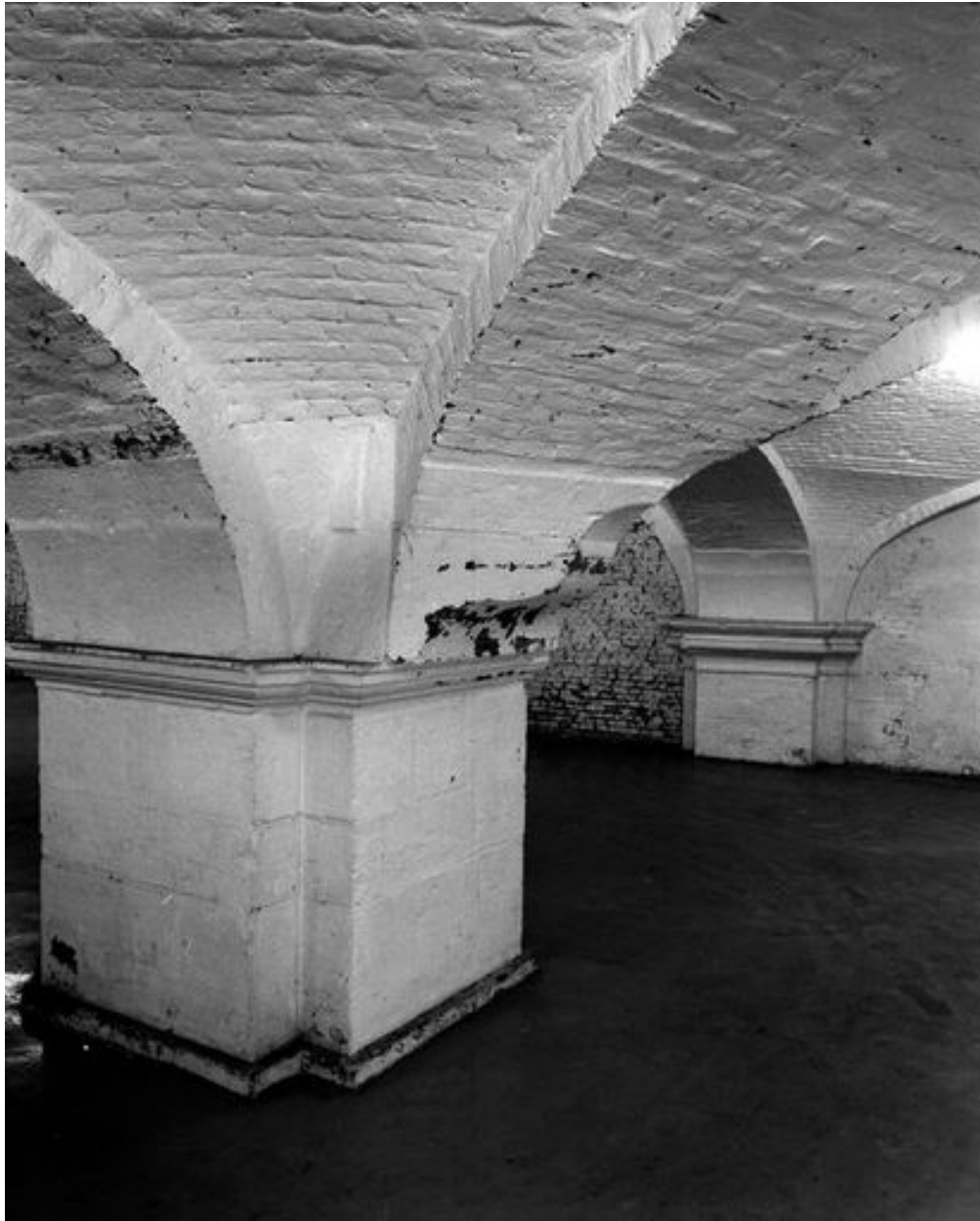
Corps de bâtiment fermant le fond de la cour d'honneur, sous-sol, salle à abside située au-dessous de la chapelle, détail d'un pilier et de la retombée des voûtes.
