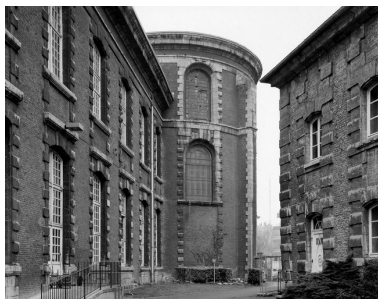
Corps de bâtiment fermant le fond de la cour d'honneur, élévation postérieure, vue en enfilade de la moitié gauche de cette élévation dont la saillie de l'abside de la chapelle occupe le centre. Phot. Philippe Dapvril
