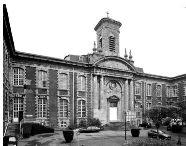
Cour d'honneur, Corps de bâtiment fermant le fond de la cour, élévation antérieure avec, au centre, la façade de la chapelle, vue générale.
