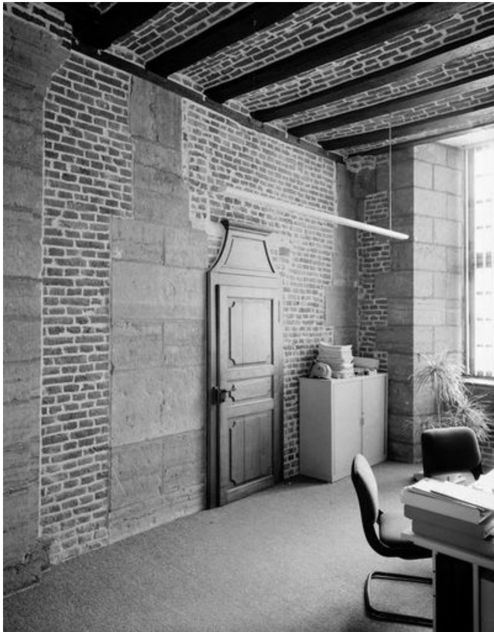
Corps de bâtiment fermant la cour d'honneur sur l'avant, rez-de-chaussée, pièce située à droite en entrant, couverte d'un plancher à entrevous en berceau segmentaire dit voûte picarde.
