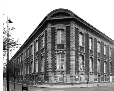
Elévation latérale gauche donnant sur la rue de Jemmapes, vue générale prise de trois-quarts droit montrant l'extrémité gauche de la façade principale. Phot. Philippe Dapvril IVR31_20025902610V
