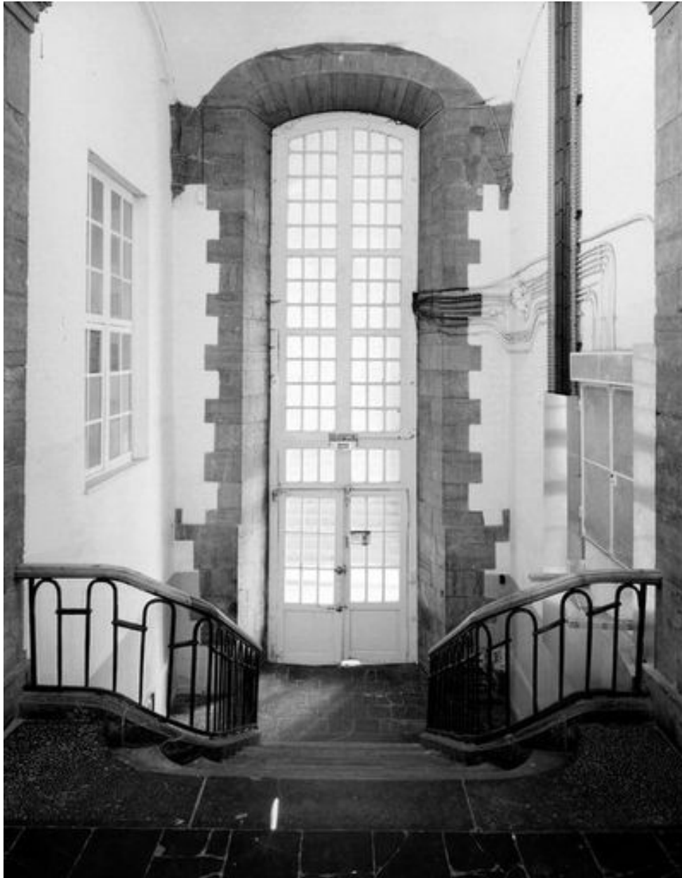
Angle des corps de bâtiment fermant respectivement le flanc droit et l'avant de la cour d'honneur, degré permettant d'accéder au rez-de-chaussée à partir de la cour des services, vue générale prise en plongée.
