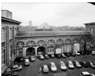
Cour des services, vue générale en regardant vers le corps de bâtiment fermant la cour sur son flanc droit.
