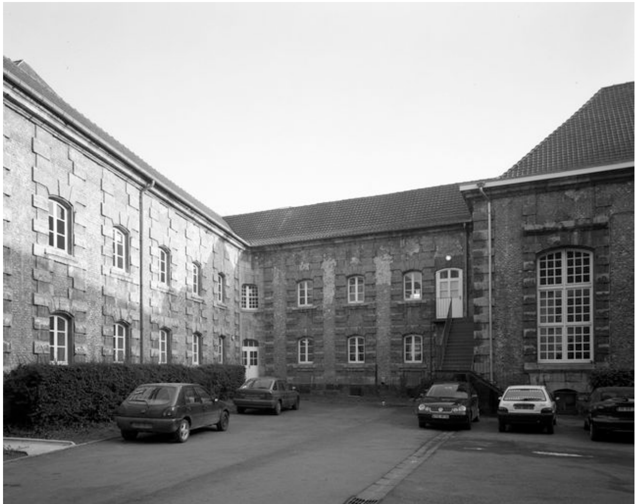
Cour des insensés, bâtiment de tracé en L, fermant le fond de la cour, qui abritait originellement les loges des insensés, élévation sur cour de la branche courte du L et de sa rencontre avec la branche longue.
