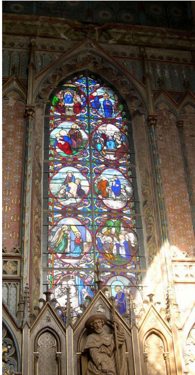
Verrière de la chapelle de la Vierge (baie 6).
