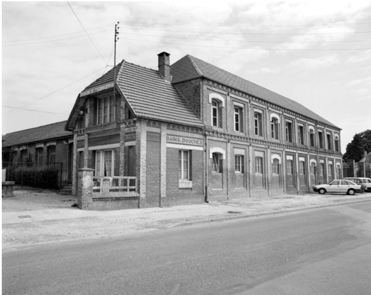
Bureau et atelier de fabrication, élévation antérieure.
