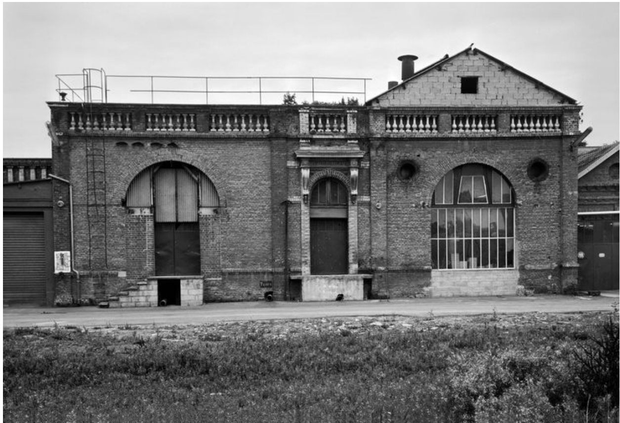
Chaufferie et salle des machines, flanc est.
