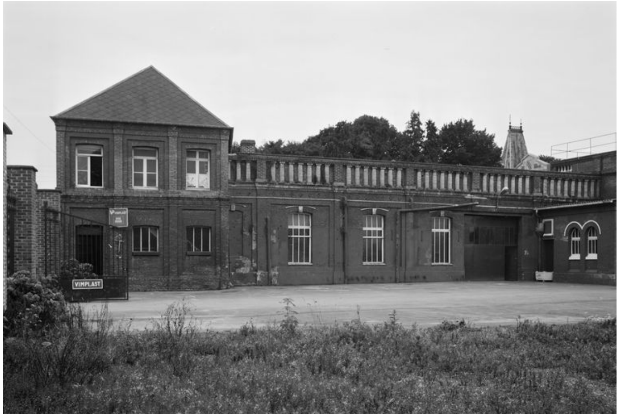
Atelier de fabrication et bureau, flanc est.
