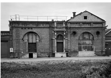
Chaufferie et salle des machines, flanc est. Phot. Thierry Lefébure
