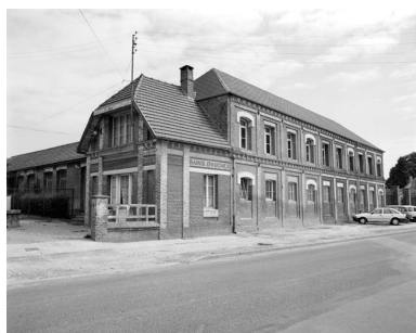
Bureau et atelier de fabrication, élévation antérieure.
