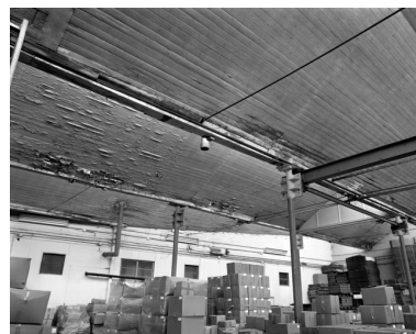
Atelier de fabrication, vue inférieure. Phot. Thierry Lefébure IVR22_19888000879X
