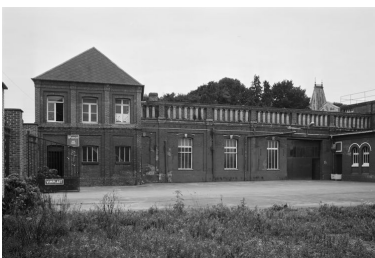
Atelier de fabrication et bureau, flanc est. Phot. Thierry Lefébure IVR22_19888000880X
