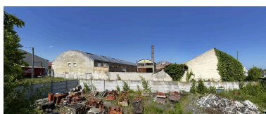
Vue d'ensemble est des ateliers. Phot. Thierry Lefébure IVR22_20158000258NUC2AQ
