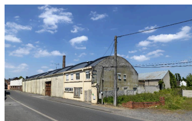
Vue d'ensemble sur rue. Phot. Thierry Lefébure IVR22_20158000257NUC2A
