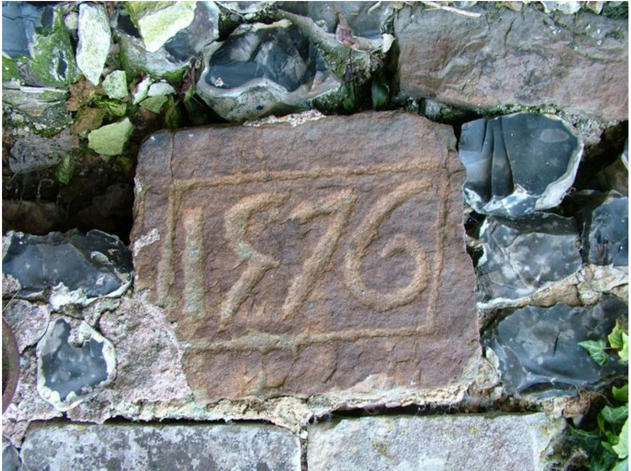
Bloc de grès inséré à la base nord du mur-pignon du choeur, et portant la date de 1576.
