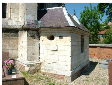
Sacristie jouxtant le pan sud-ouest de l'abside. Phot. Frédéric Fournis IVR22_20108001783NUCA
