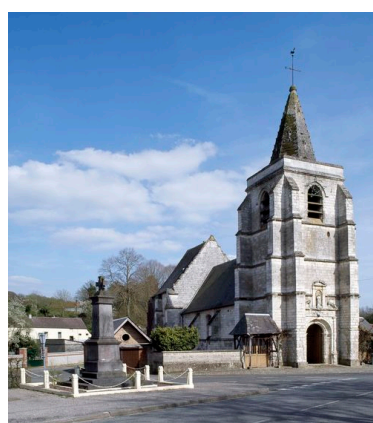
Vue générale depuis le nord-ouest. Phot. Marie-Laure Monnehay-Vulliet IVR22_20108000125XA
