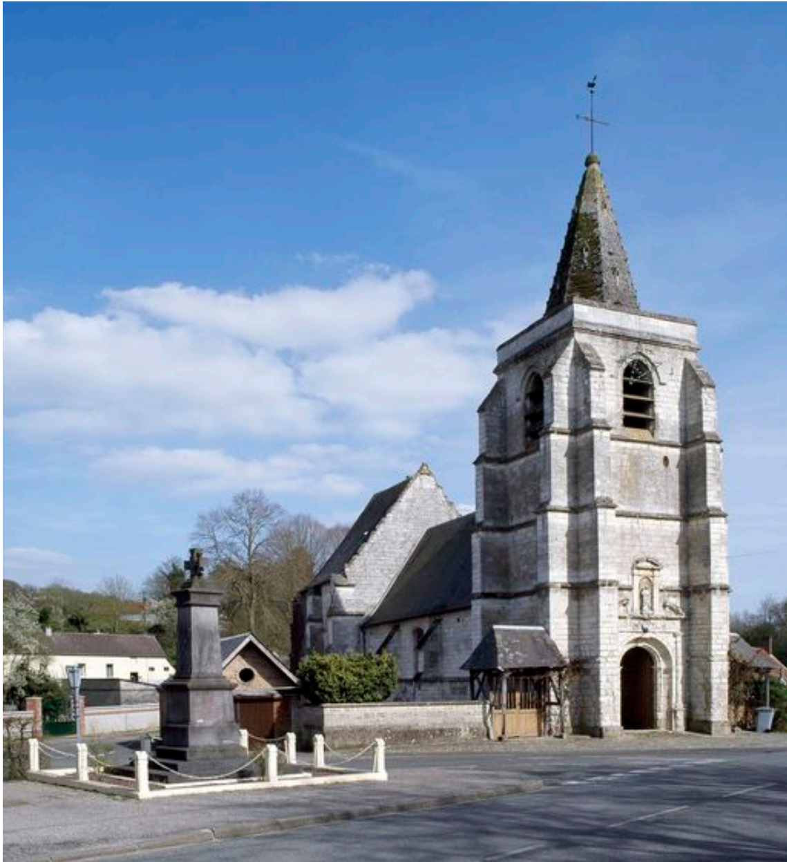
Vue générale depuis le nord-ouest.
