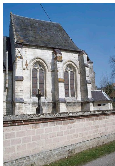
Vue latérale du chevet. Phot. Marie-Laure Monnehay-Vulliet IVR22_20118000263XA
