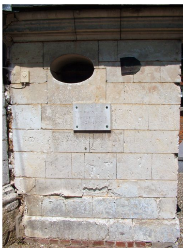
Mur ouest de la sacristie. Phot. Frédéric Fournis IVR22_20108001774NUCA
