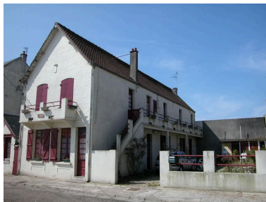
Vue de trois-quarts sur les façades sur rue et latérale droite.
