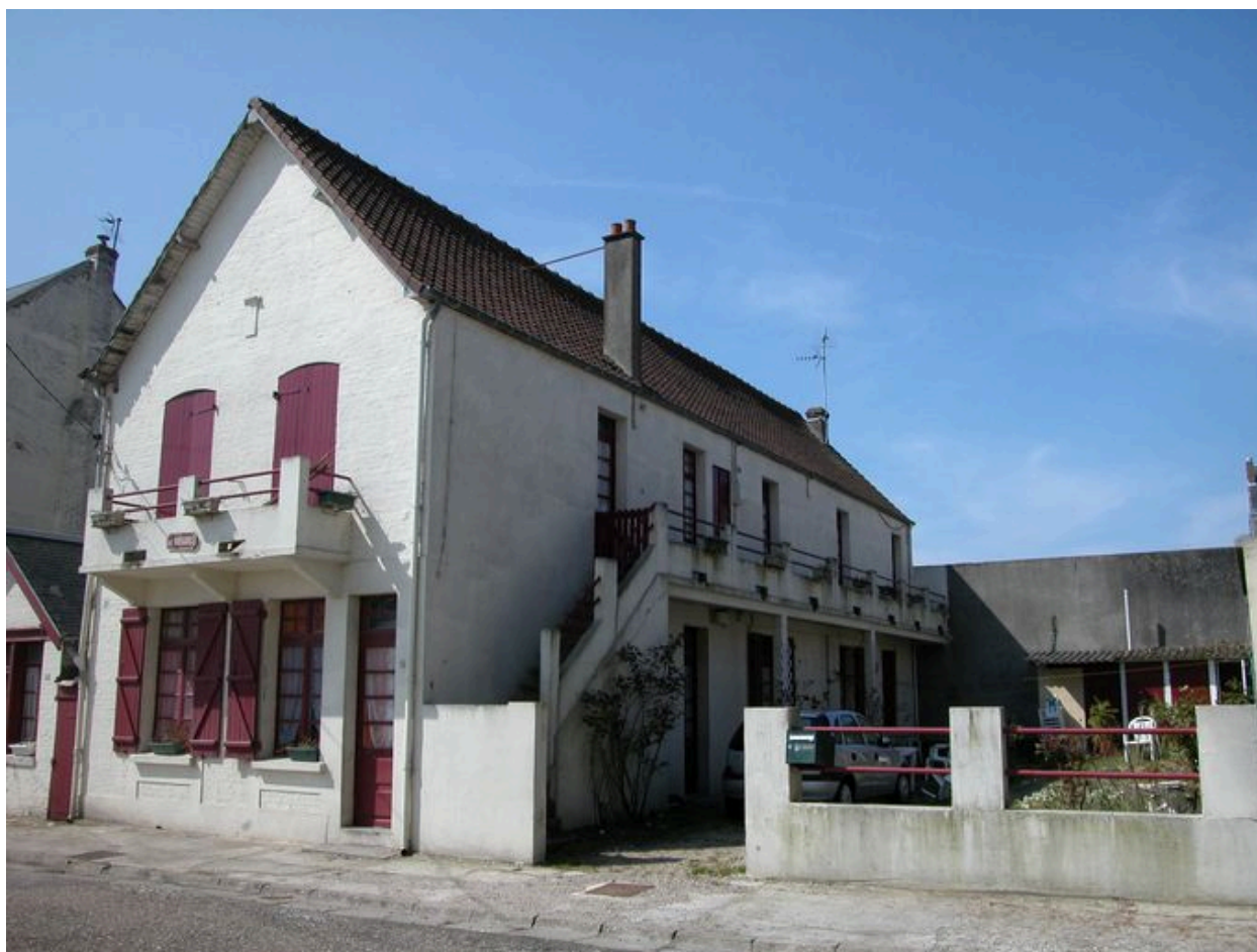
Vue de trois-quarts sur les façades sur rue et latérale droite.
