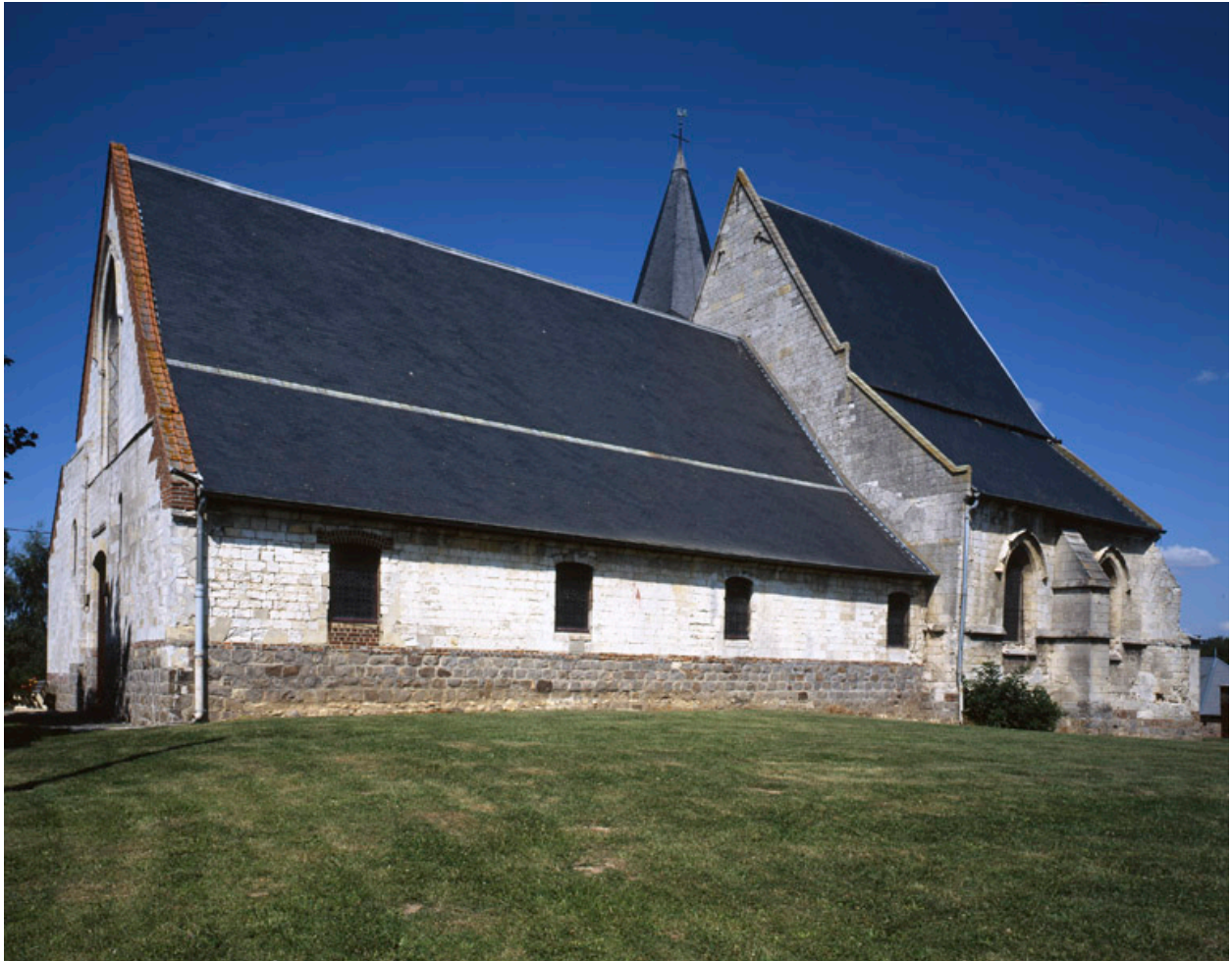
Vue depuis le sud-ouest.
