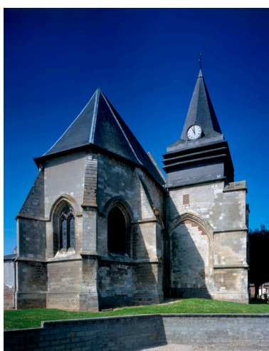
Vue du chevet. Phot. Irwin Leullier IVR22_19988000618VA
