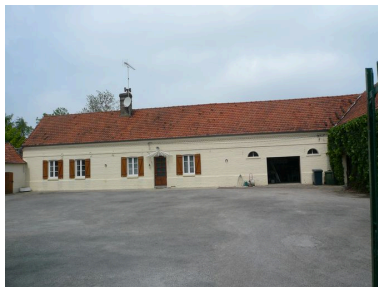
Vue du logis. Phot. Inès Guérin IVR22_20068005624NUCA
