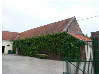
Vue de la grange. Phot. Inès Guérin IVR22_20078005803NUCA
