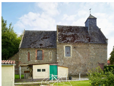
Vue générale de la façade méridionale. Phot. Pierre Thibaut IVR31_20155901599NUCA
