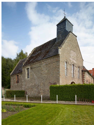
Vue générale de trois quarts de la chapelle. Phot. Pierre Thibaut IVR31_20155901598NUCA
