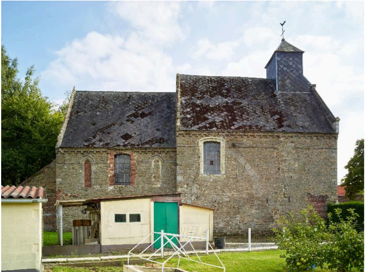
Vue générale de la façade méridionale.
