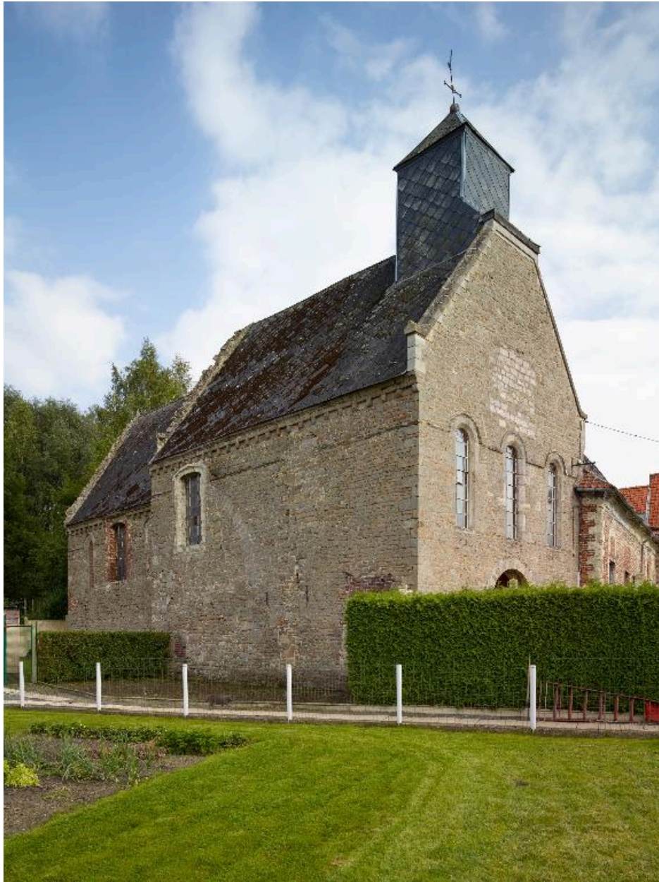
Vue générale de trois quarts de la chapelle.
