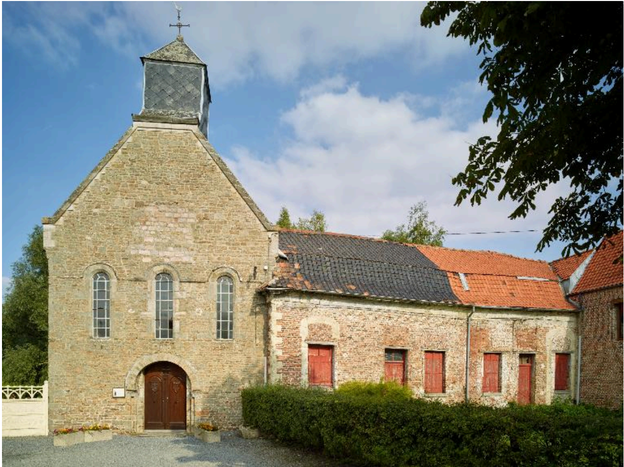
Vue générale de la chapelle et du prieuré attenant.
