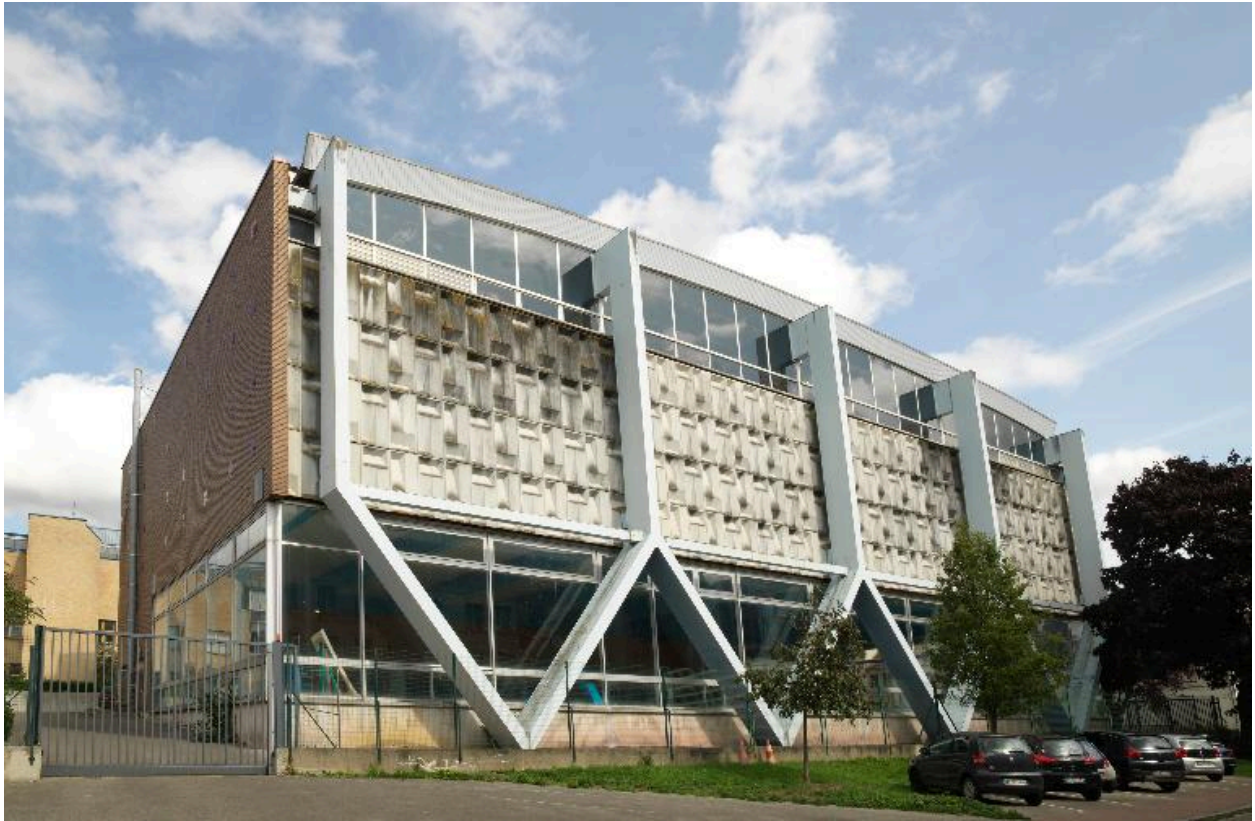
Façade sud, sur la rue de la Commune de Paris; au rez-de-chaussée, baies vitrées donnant sur le bassin.
