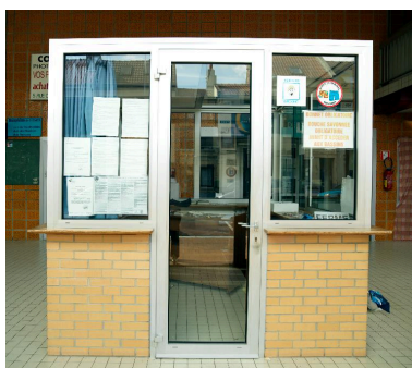
Guichet-caisse. Phot. Marie-Laure Monnehay-Vulliet IVR32_20176200629NUCA2A
