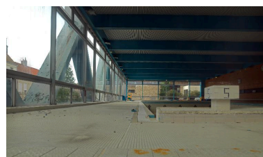
Vue du bassin sportif et des plages, côté baies vitrées. Phot. Marie-Laure Monnehay-Vulliet IVR32_20176200630NUCA2A
