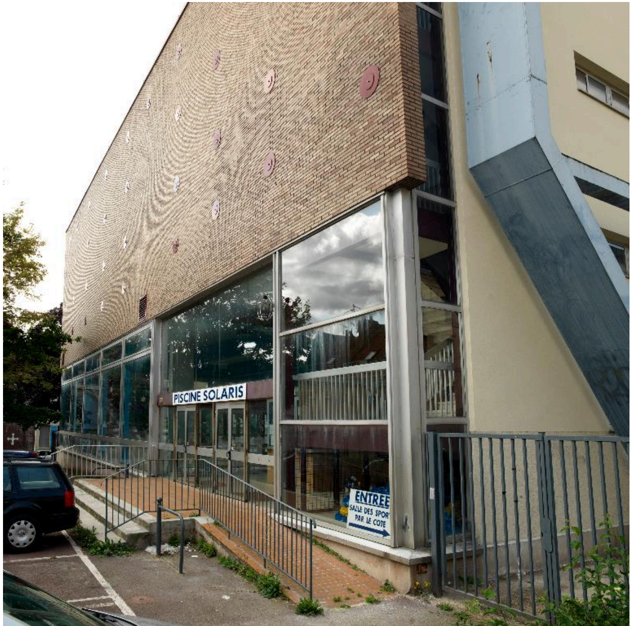
Détail de l'entrée de la piscine.
