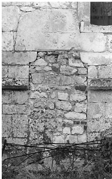
Elévation nord du choeur : détail d'une porte à coussinet avec entablement portant une croix en relief (14e siècle ?).
