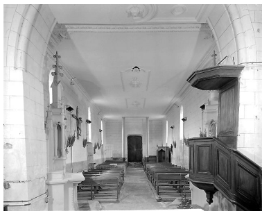
Vue intérieure du choeur vers la nef.
