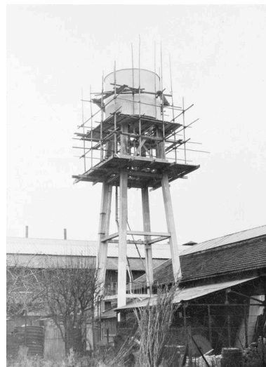
Château d'eau (AP). Repro. Charronnière Fabrice IVR22_19866000314XB
