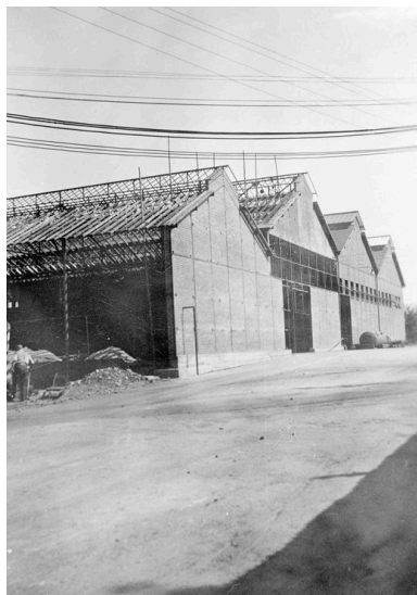
Vue de quatre ateliers de fabrication en cours de reconstruction, vers 1950 (AP). Repro. Charronnière Fabrice IVR22_19866000322XB
