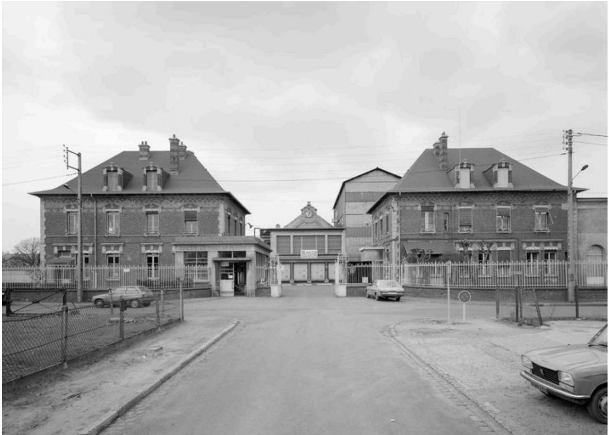
Vue générale des bâtiments d'entrée.
