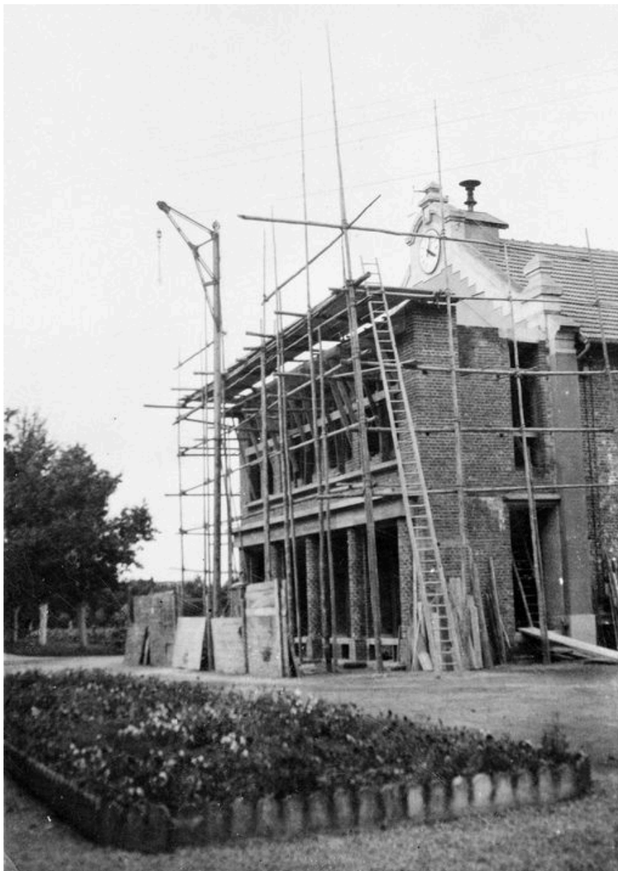
Extension de l'usine (AP).
