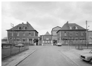
Vue générale des bâtiments d'entrée.
