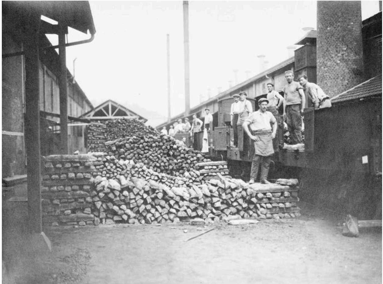
Vue de la chauffe (AP).
