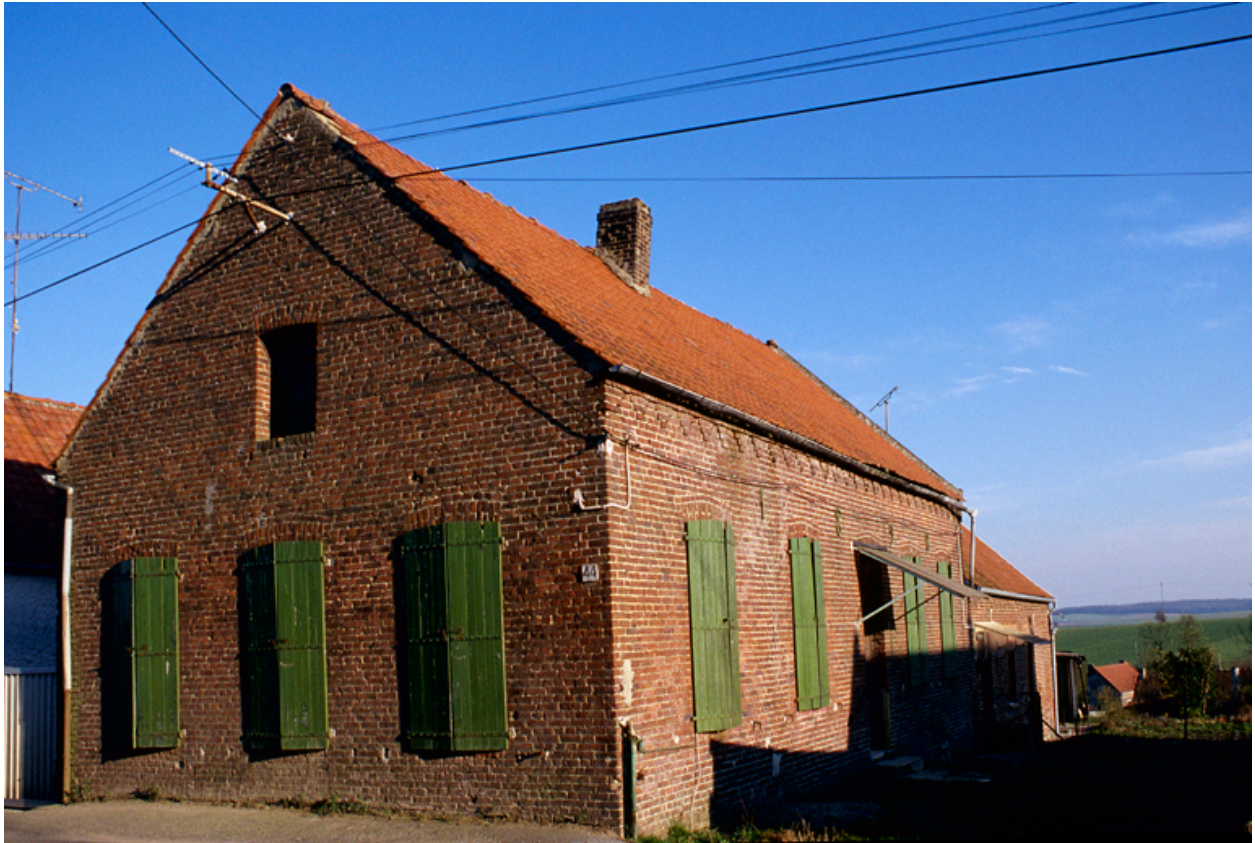
Vue d'ensemble nord-ouest de l'édifice daté de 1890.
