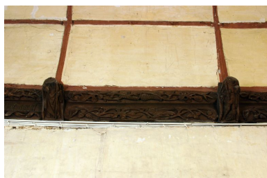
Vue détaillée de la sablière haute du choeur avec décor végétal et blochets bûchés. Phot. Irwin Leullier IVR22_20078000128NUCA
