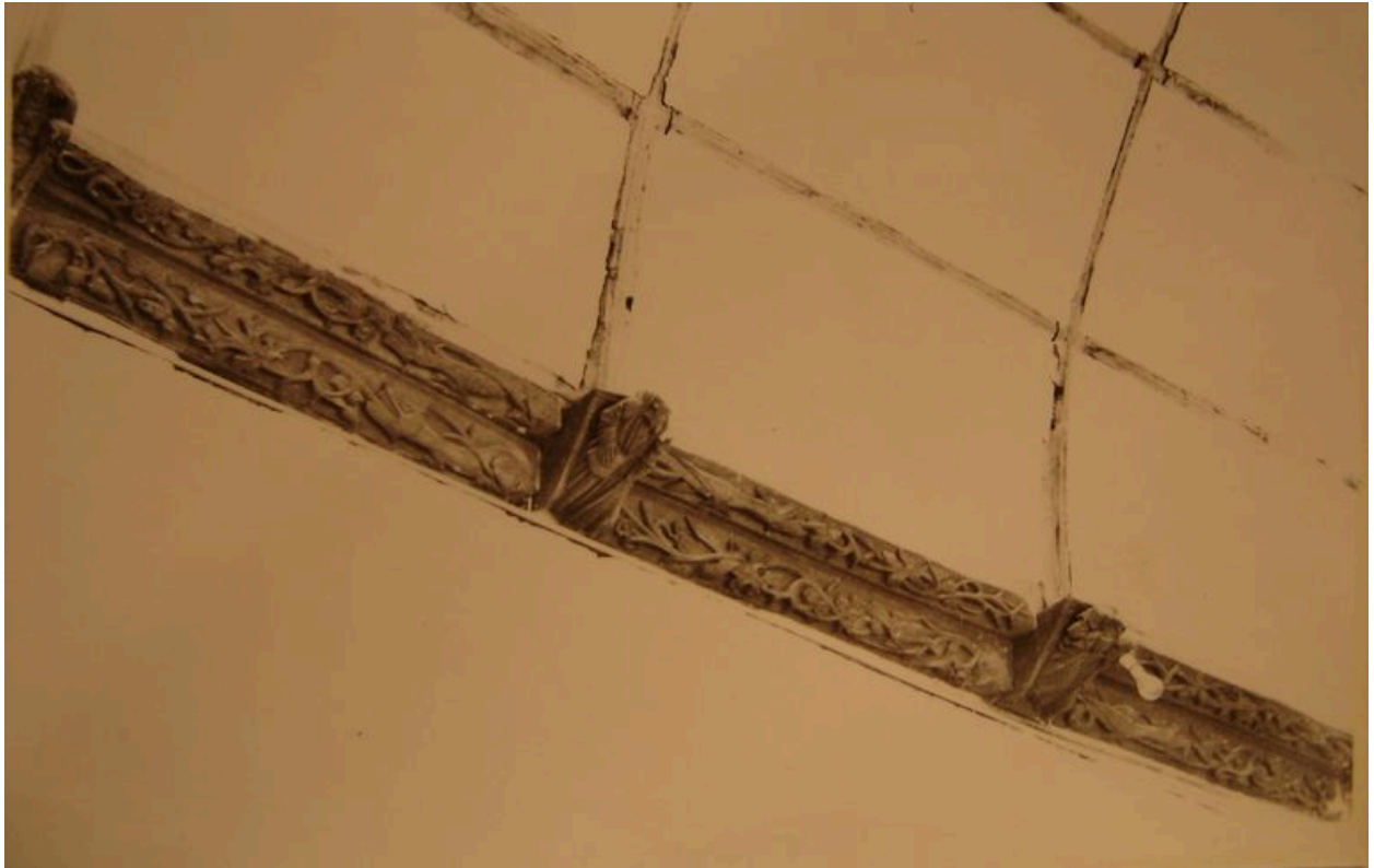
Vue détaillée de la sablière haute du choeur.
