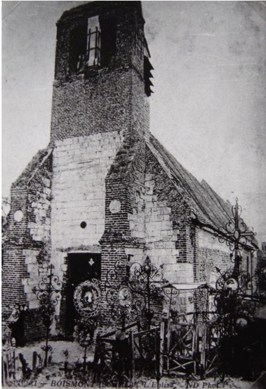
Vue du clocher-porche au début du 20e siècle.
