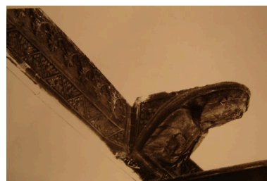
Vue détaillée d'un blochet bûché.
