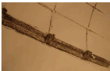
Vue détaillée de la sablière haute du chœur.
