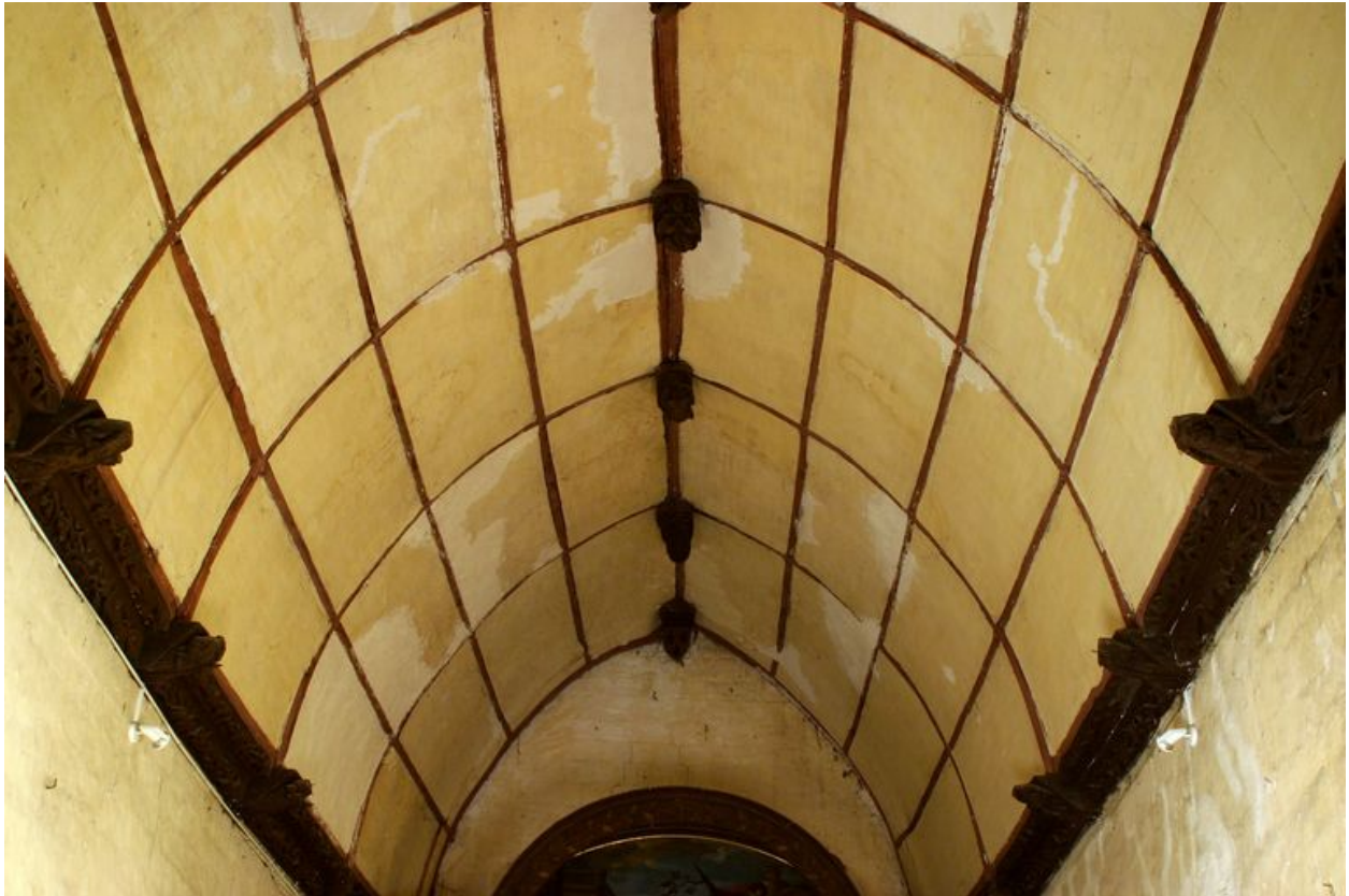
Vue de la charpente du choeur.
