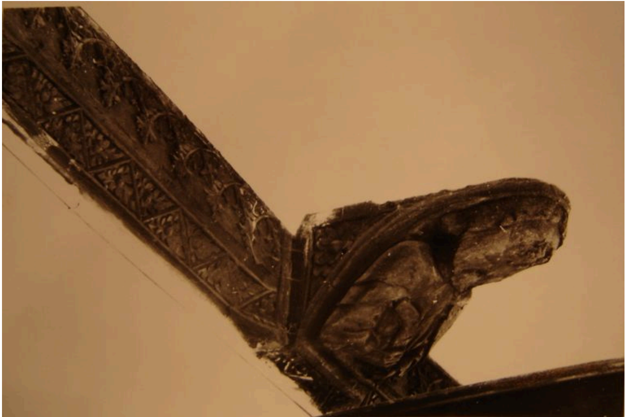
Vue détaillée d'un blochet bûché.
