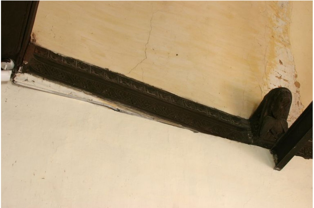
Vue détaillée de la sablière haute de la nef avec motifs géométriques et blochet bûché.
