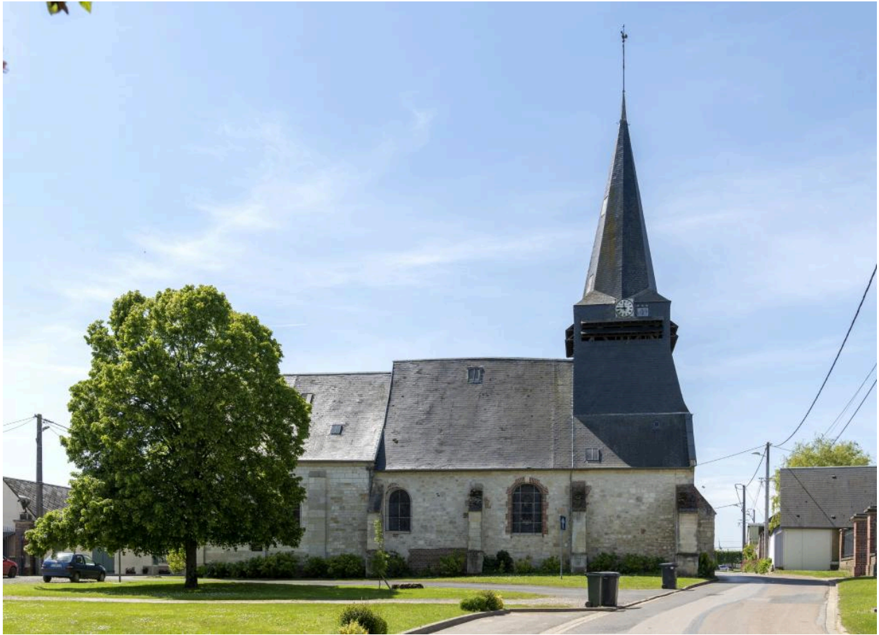
Vue depuis le nord.
