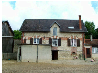
Vue générale. Phot. Inès Guérin IVR22_20030202201NUCA
