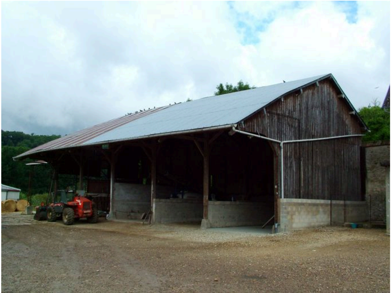
Vue du hangar.
