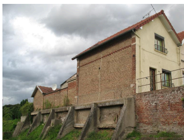
Contrefort de terrasse en béton armé rachatant le dénivelé à l'aplomb du logement. Phot. Bertrand Fournier IVR22_20128005086NUCA
