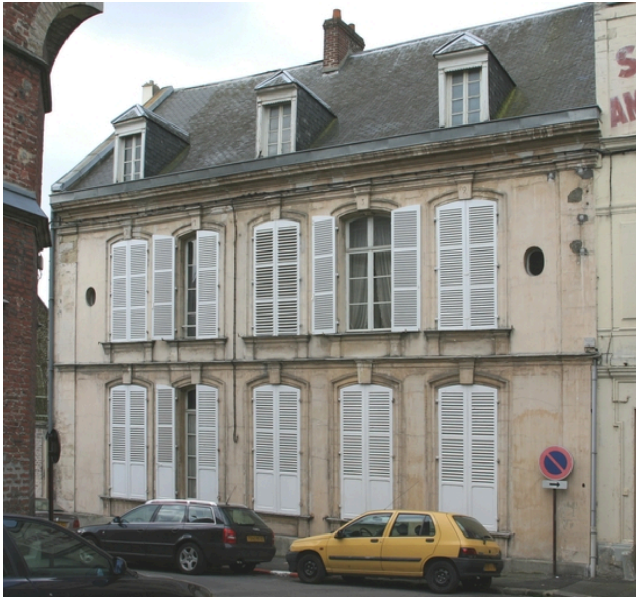
Façade antérieure du logement patronal.
