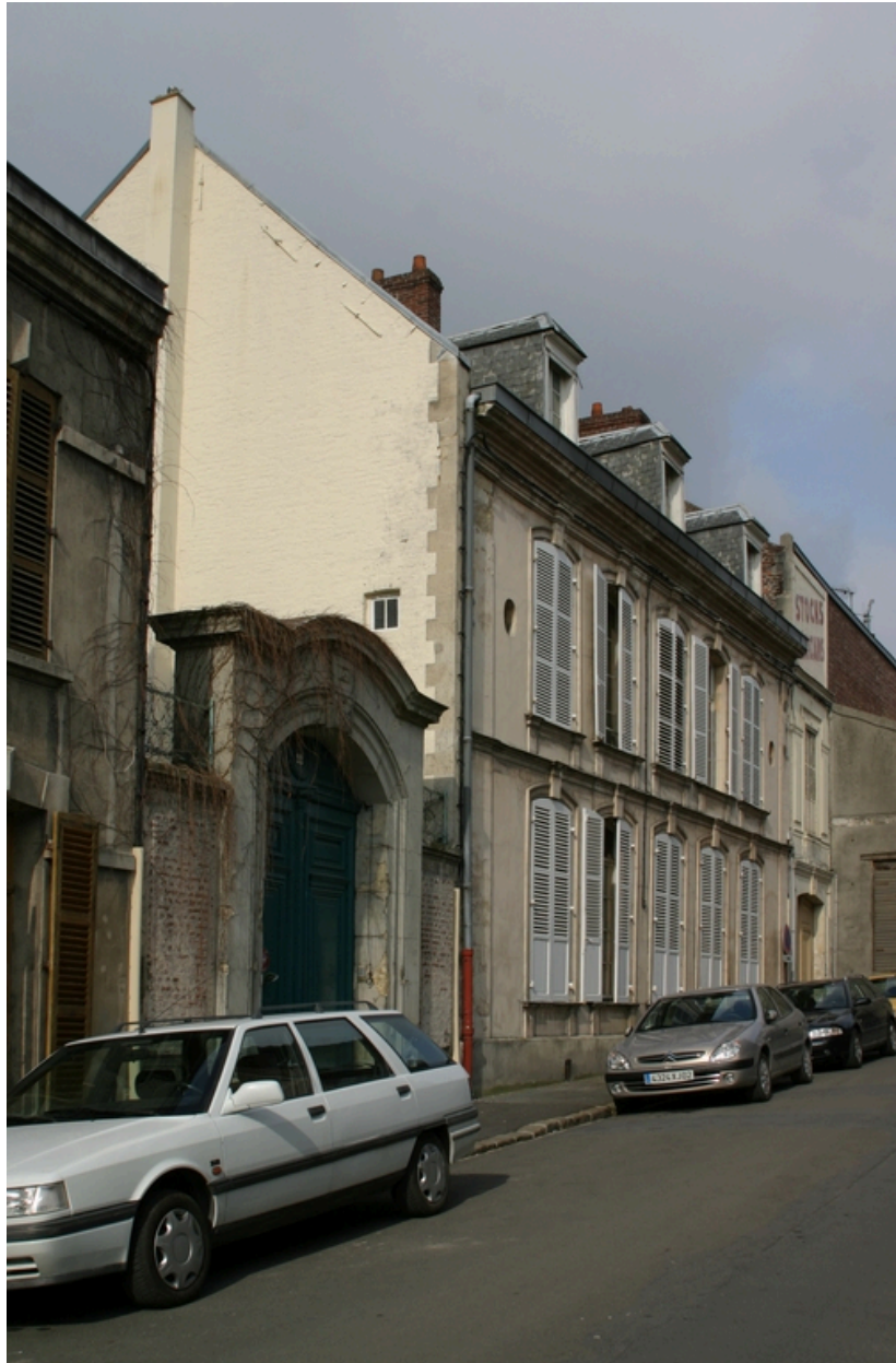
Façade antérieure du logement patronal.
