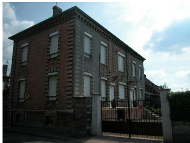
Vue de trois-quarts, élévation postérieure. Phot. Elisabeth Justome IVR22_20058002578NUCA
