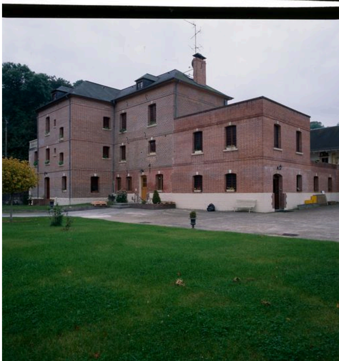
Vue d'ensemble nord-est du moulin.
