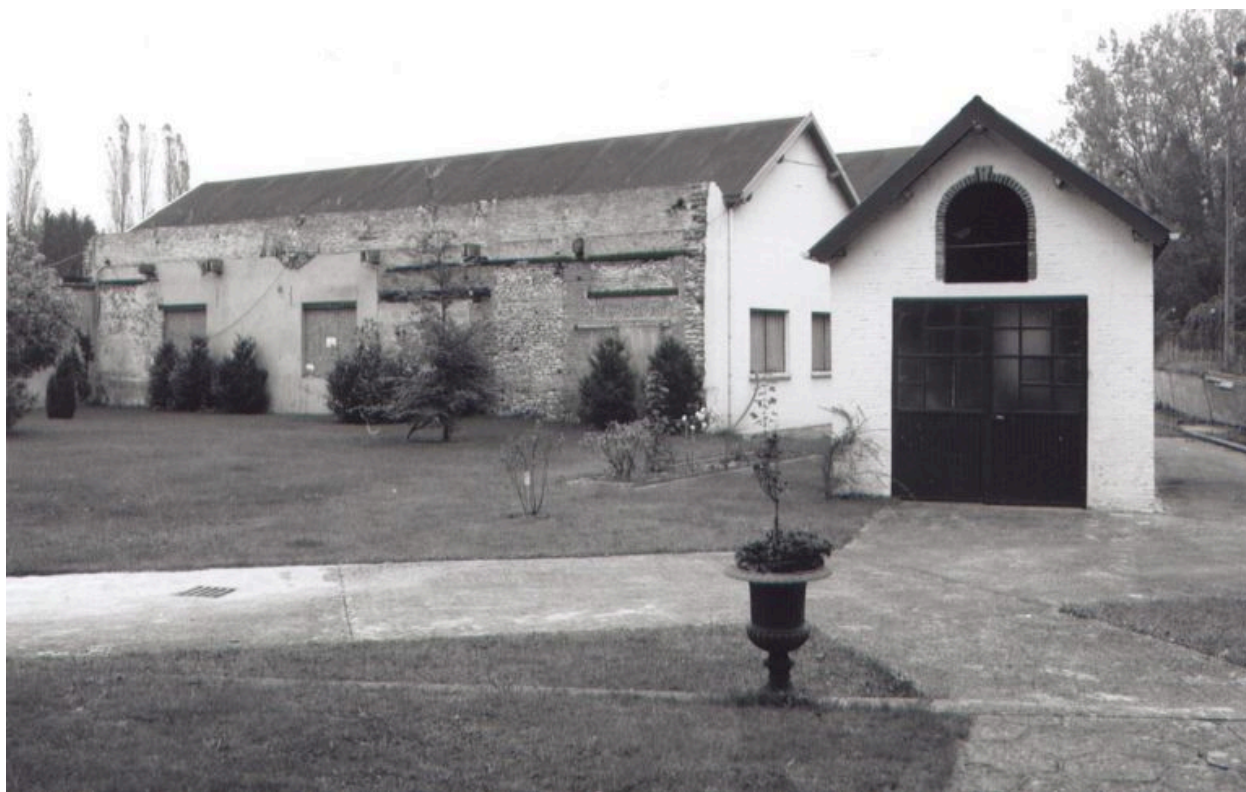
Les vestiges d'un ancien bâtiment de la minoterie.
