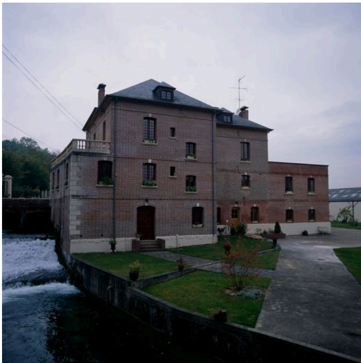
Vue générale de l'usine, coté est.
