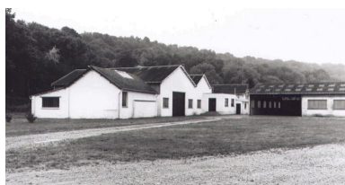
Les ateliers de fabrication et les entrepôts. Phot. Thierry Lefébure IVR22_20026000986X
