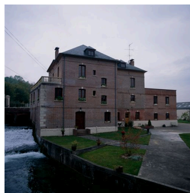
Vue générale de l'usine, coté est.
