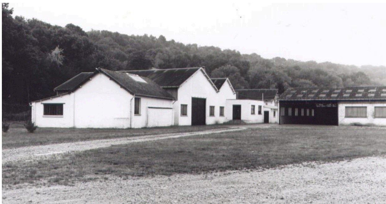
Les ateliers de fabrication et les entrepôts.
