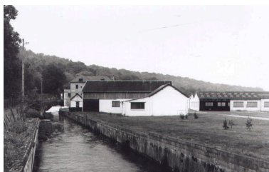
Vue d'ensemble du site industriel.
