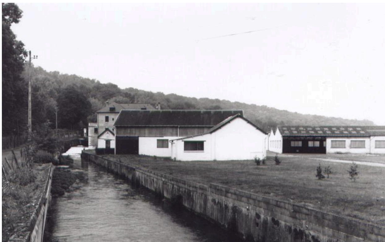
Vue d'ensemble du site industriel.
