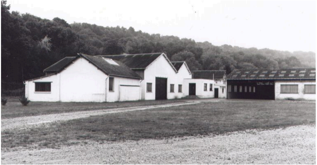
Les ateliers de fabrication et les entrepôts.
