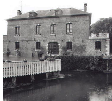
L'usine, façade ouest. Phot. Thierry Lefébure IVR22_20026000980X
