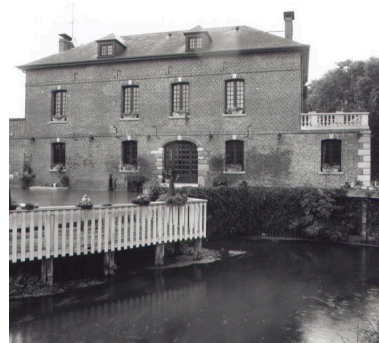
L'usine, façade ouest. Phot. Thierry Lefébure IVR22_20026000980X
