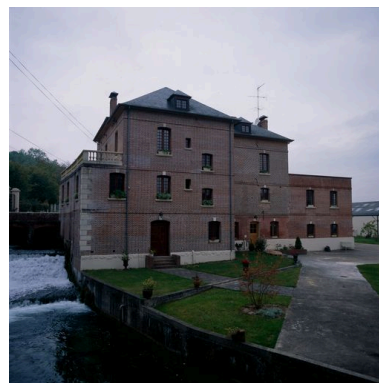
Vue générale de l'usine, coté est.
