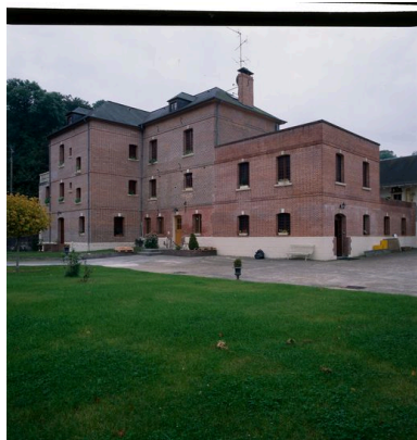
Vue d'ensemble nord-est du moulin. Phot. Thierry Lefébure IVR22_20026001056XA
