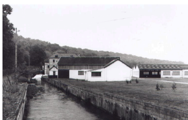
Vue d'ensemble du site industriel.
