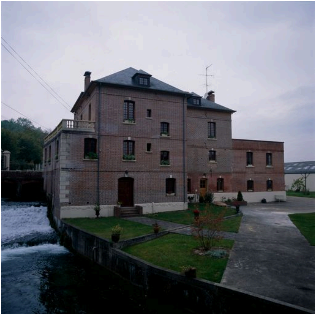
Vue générale de l'usine, coté est.
