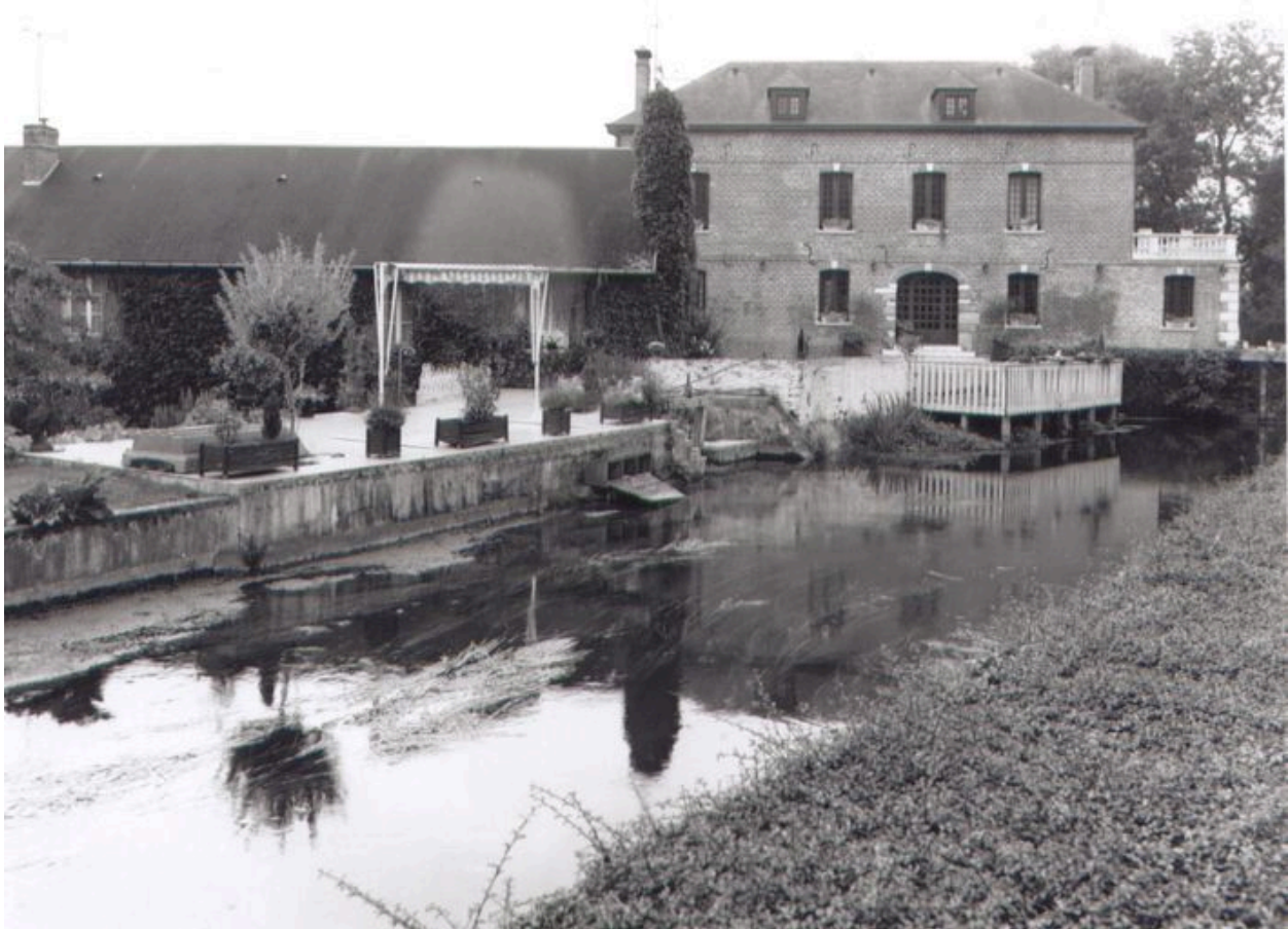
Vue d'ensemble de l'usine, côté ouest.
